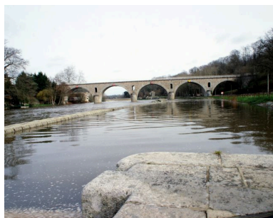
Vue d'ensemble, depuis l'écluse de la Fourmondière inférieure en aval. Phot. François Lasa IVR52_20025300402XA
