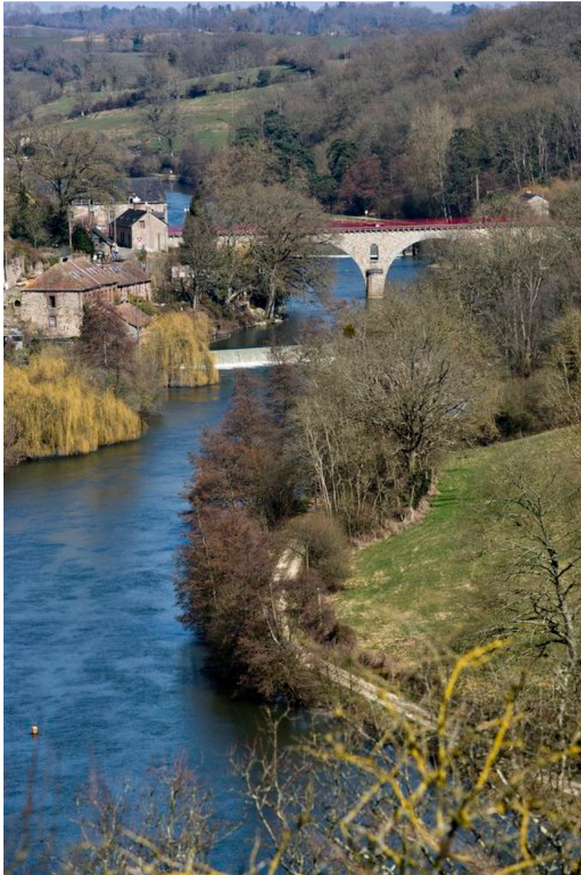
Le site d'écluse de la Fourmondière-inférieure et le pont de Rochefort vus depuis la rive droite de la Mayenne au lieu-dit le Petit-Coudray à Andouillé.
