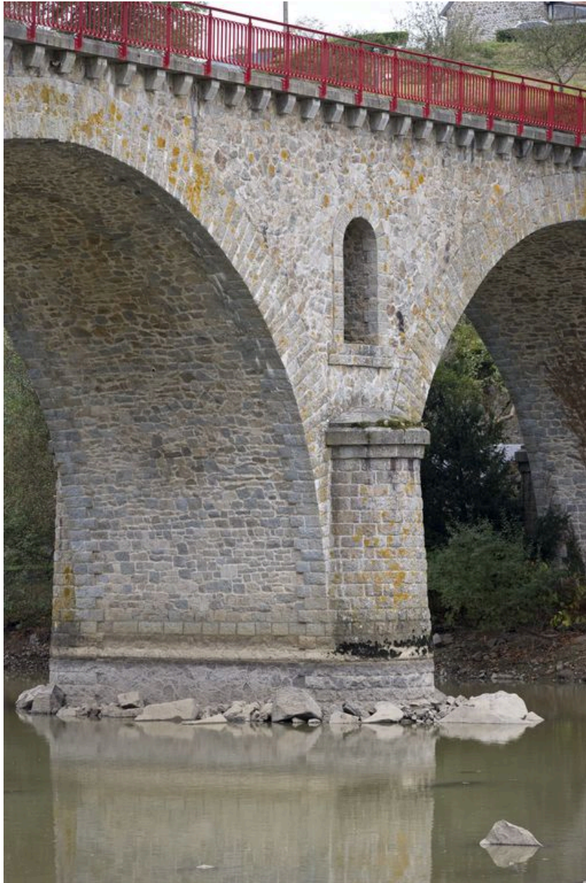
Vue d'une pile, pendant les écourues de 2009.
