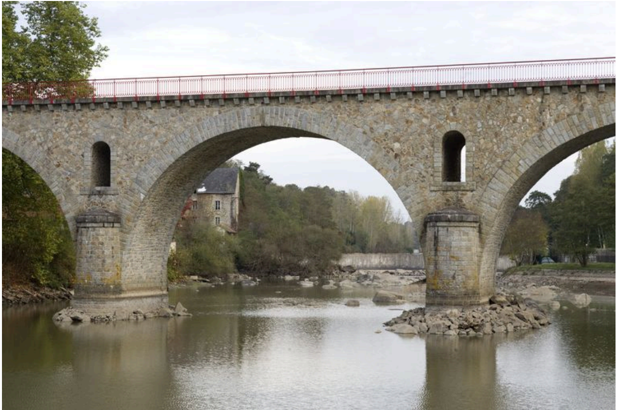
Vue partielle depuis l'aval pendant les écourues de 2009.
