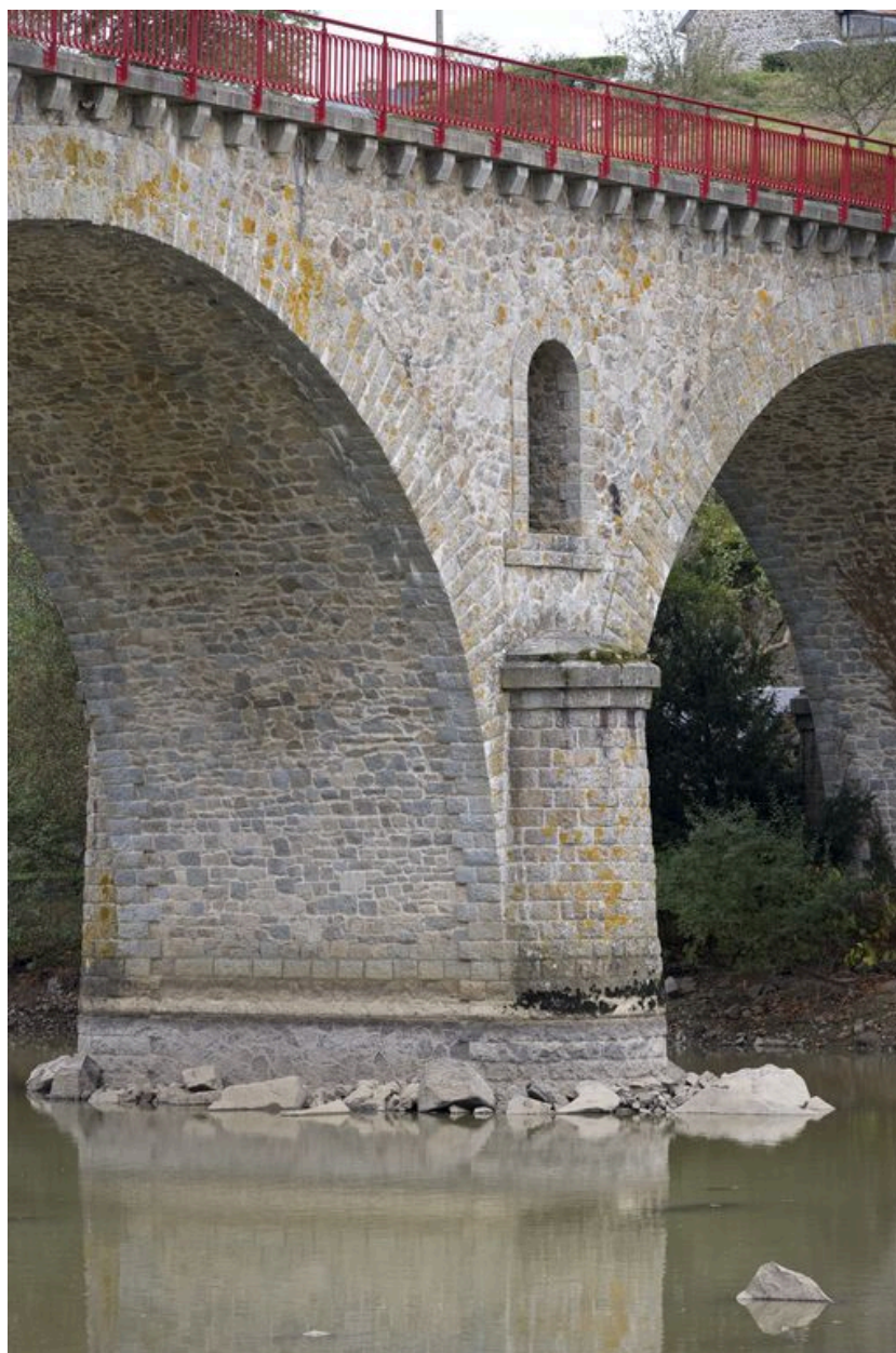
Vue d'une pile, pendant les écurues de 2009.
