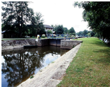
Le canal, l'écluse, l'ancien fournil (remanié) et la maison éclusière vus d'amont depuis la digue. Phot. François Lasa IVR52_20025300985XA
