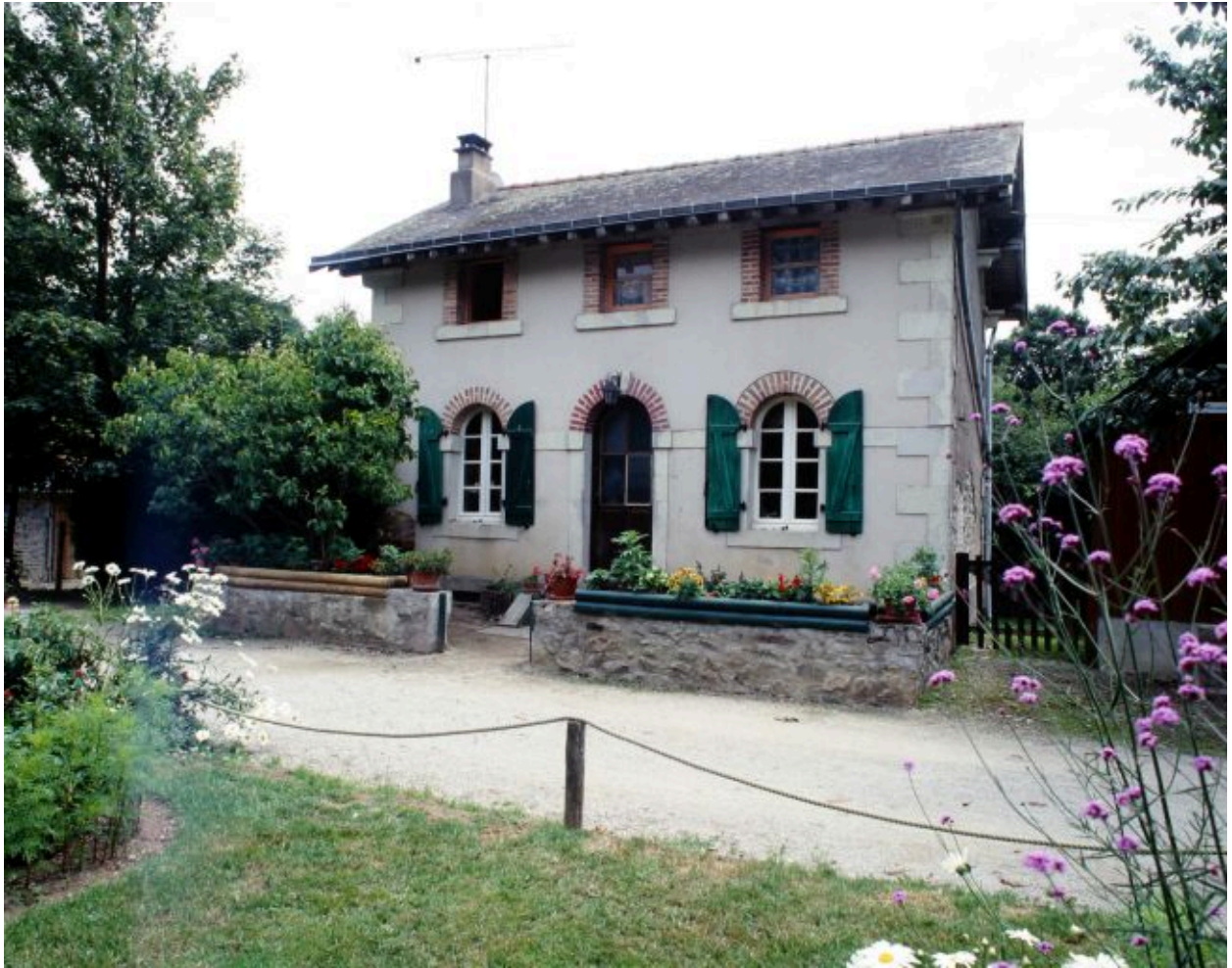
La maison éclusière.
