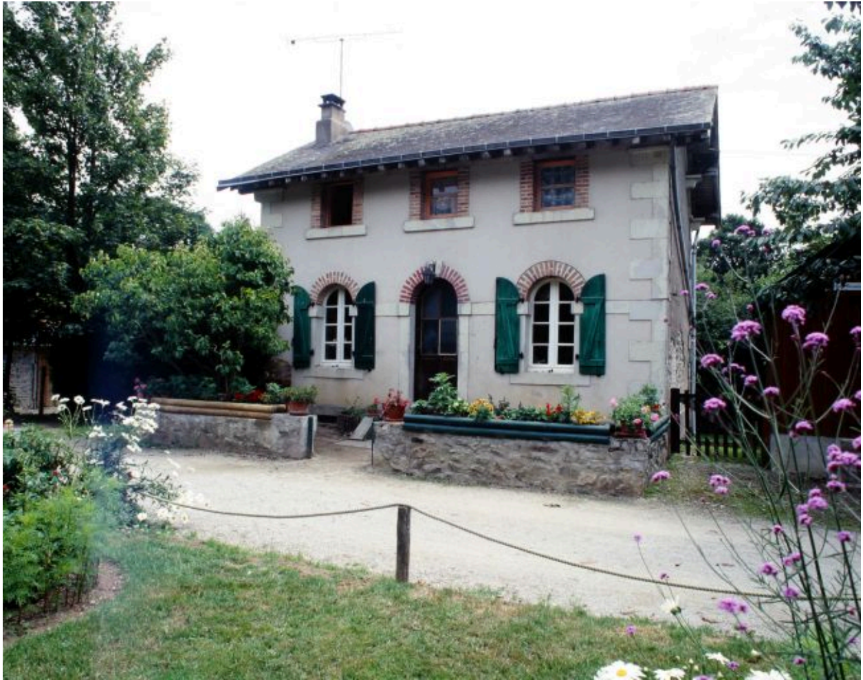
La maison éclusière.
