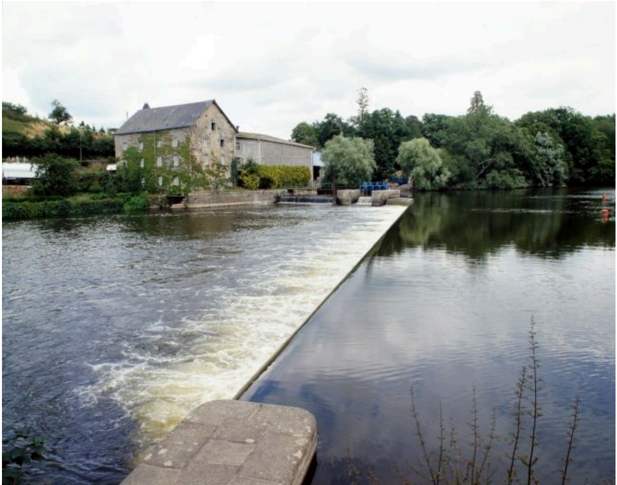
Le moulin, le pertuis et le barrage vus d'aval depuis l'extrémité de la digue du canal d'accès à l'écluse.
