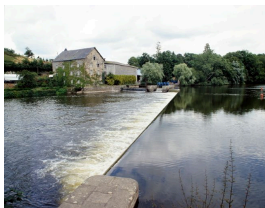
Le moulin, le pertuis et le barrage vus d'aval depuis l'extrémité de la digue du canal d'accès à l'écluse. Phot. François Lasa IVR52_20025300987XA
