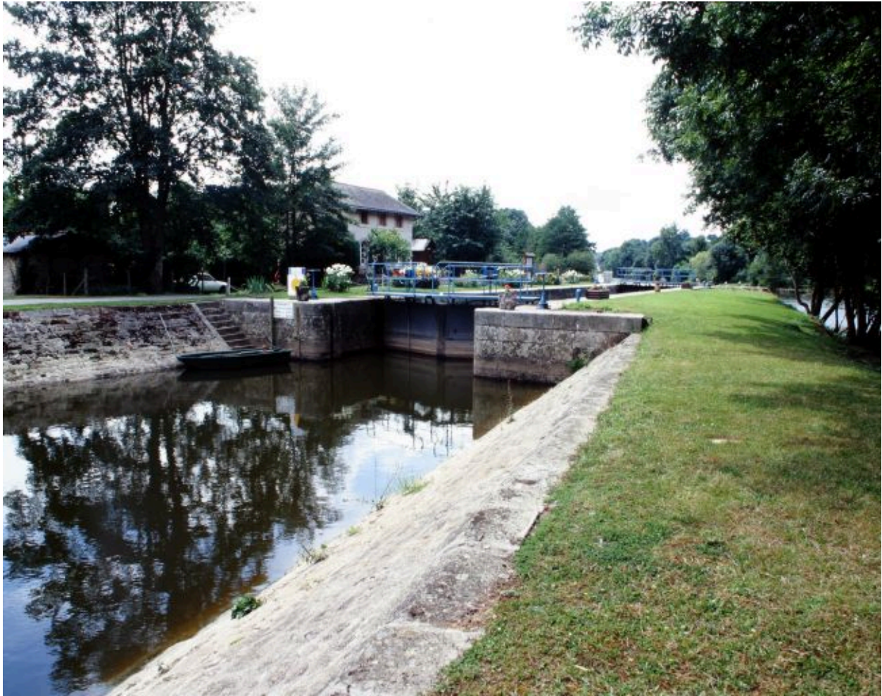
Le canal, l'écluse, l'ancien fournil (remanié) et la maison éclusière vus d'amont depuis la digue.
