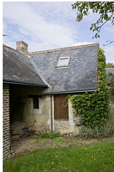
La vieille maison, élévation antérieure. Phot. Pierre-Bernard Fourny IVR52_20137200205NUCA
