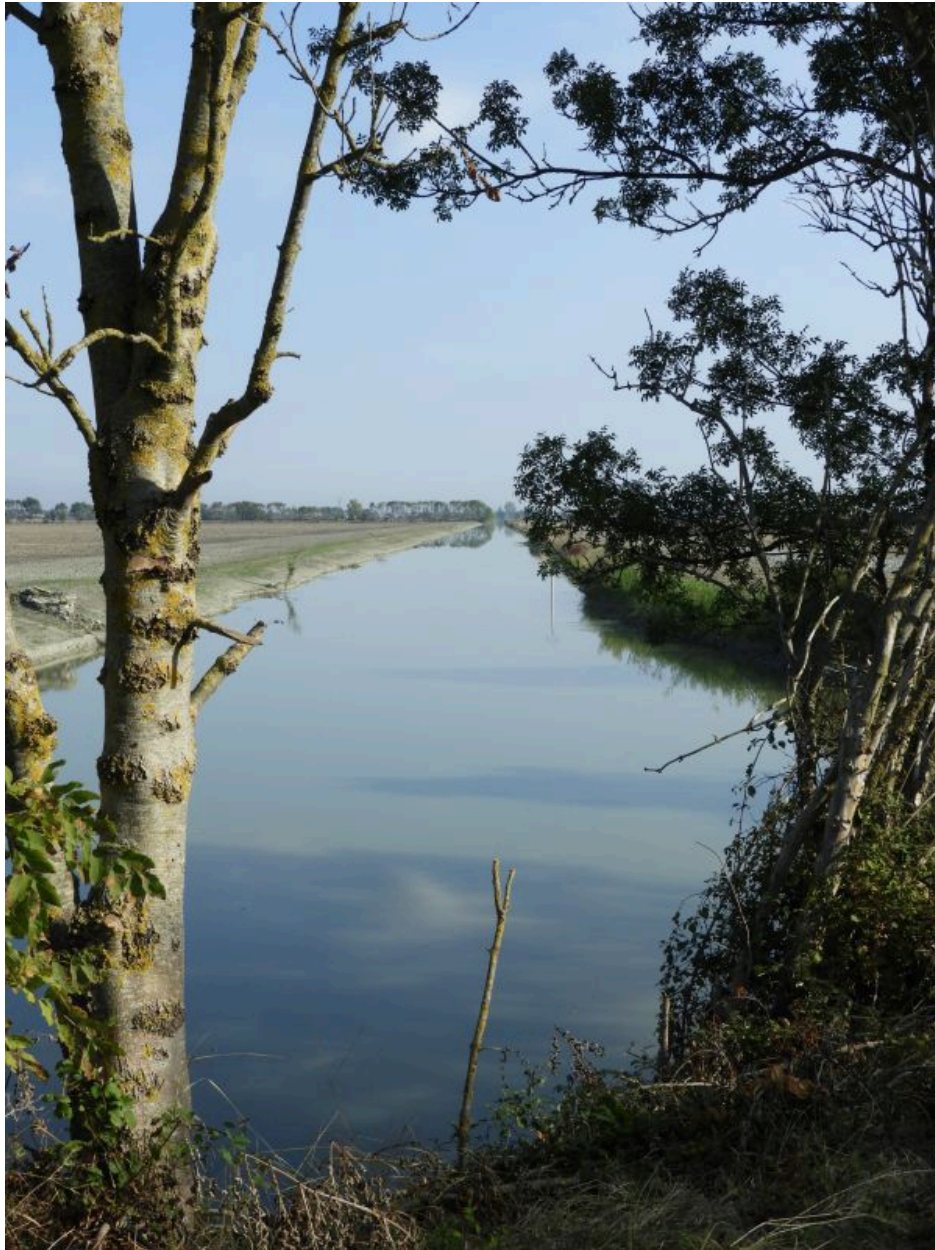
Le canal à son point de confluence avec le canal de Vix, vu en direction du nord-est.
