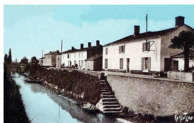
Le canal dans la traversée du village du Pont aux chèvres, en direction du sud-ouest, au début du 20e siècle.
