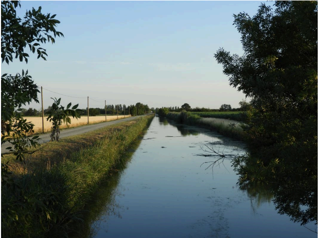
La partie amont du canal vue depuis le pont de Bois, en direction du sud-ouest.
