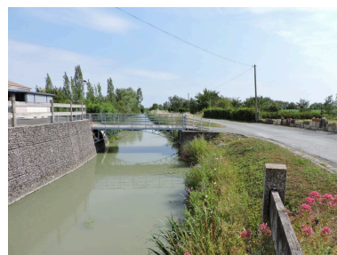
Le canal à son arrivée dans le village du Pont aux chèvres, en amont du pont, vu en direction du nord-est. Phot. Yannis Suire IVR52_20198502590NUCA
