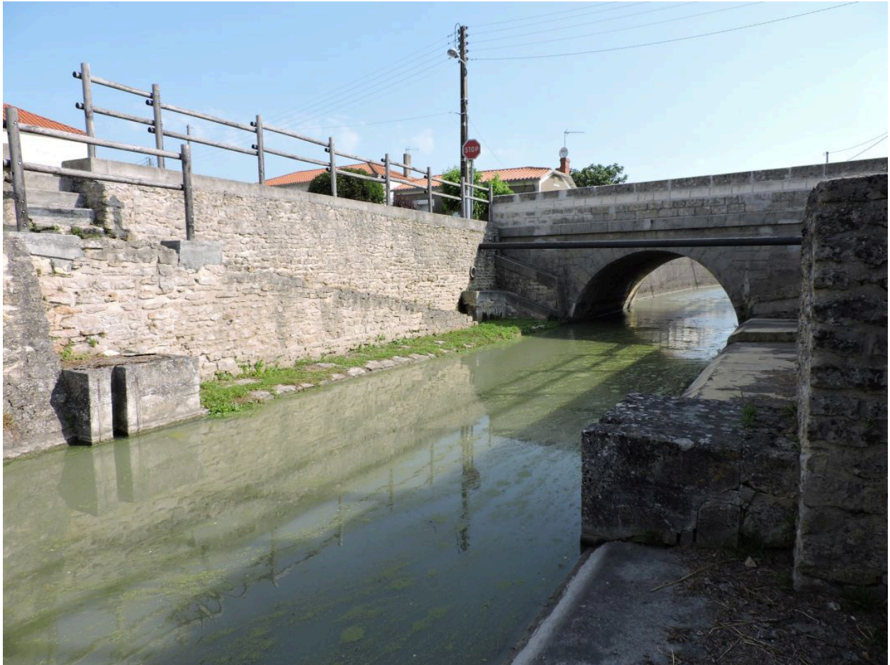
Le canal passant sous le pont aux chèvres, vu depuis l'aval.
