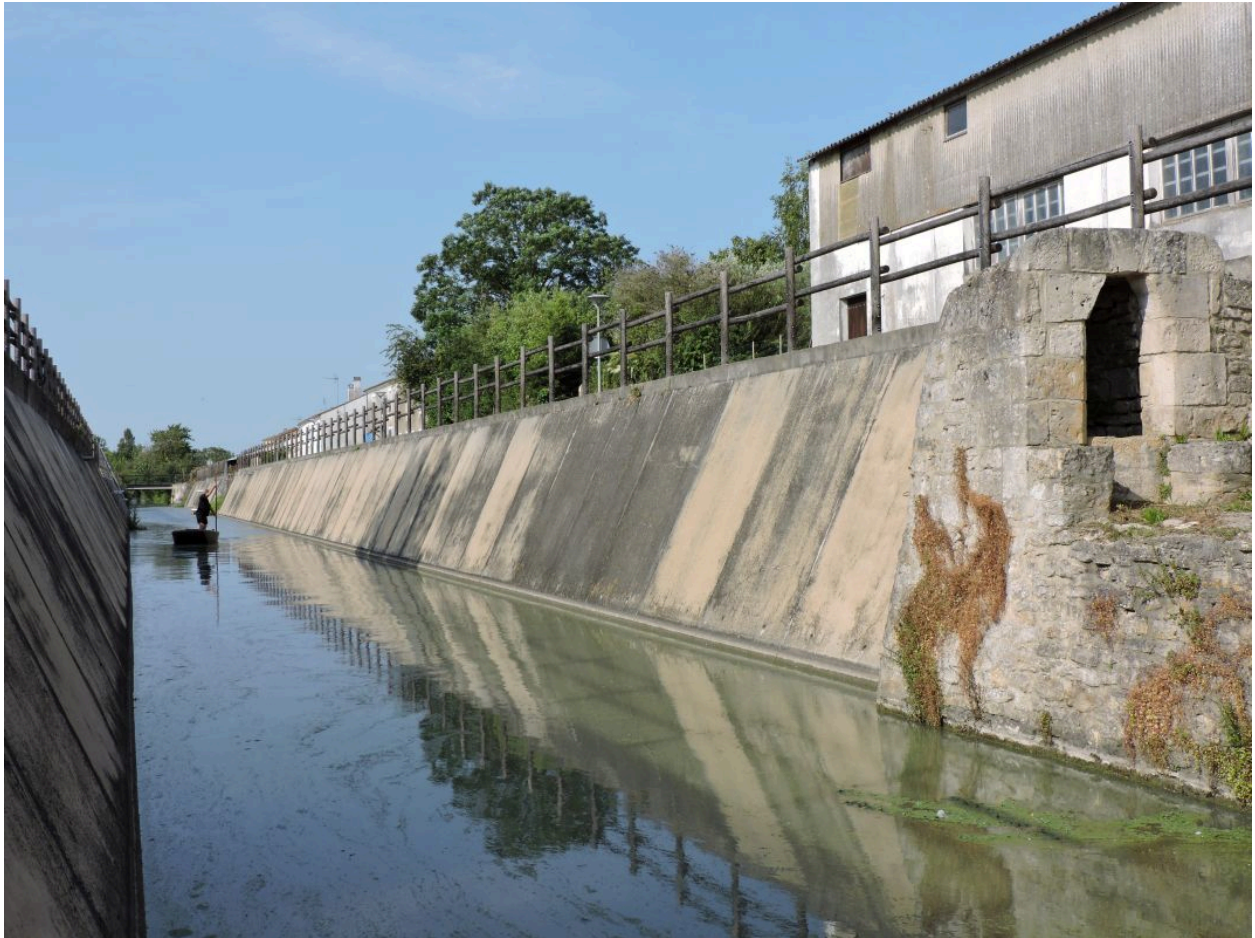
Les abords du canal, maçonnés, en aval du pont aux chèvres, en direction du sud-ouest.
