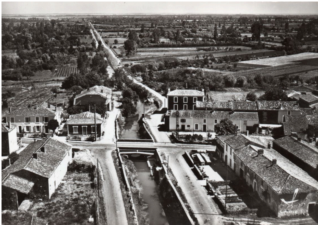
Vue aérienne du canal dans la traversée du village du Pont aux chèvres, en direction du nord-est, vers 1950.
