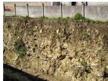
Bords du canal creusés dans la banche, avant recouvrement par un parement en béton en 2005.
