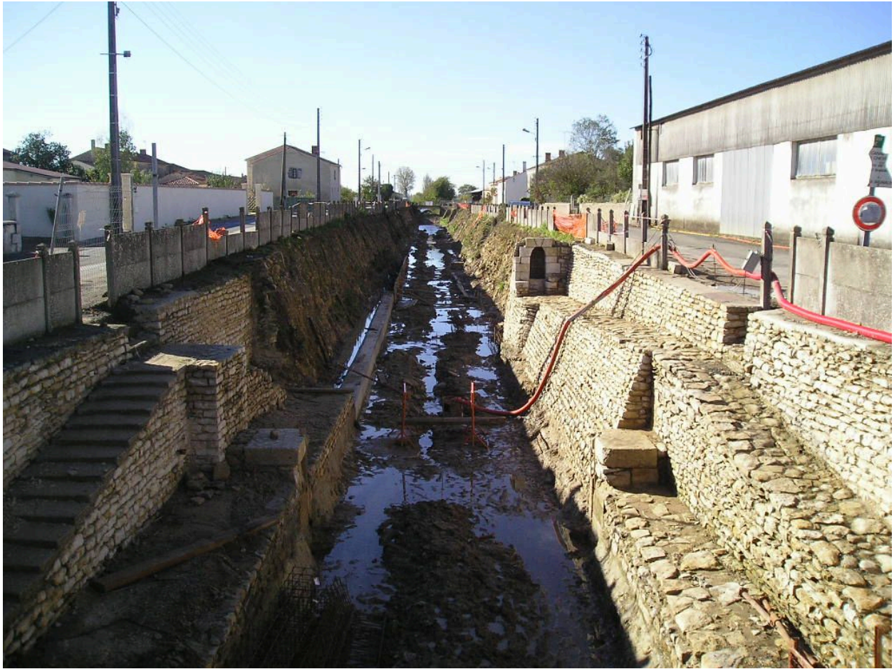
Travaux de restauration des bords du canal en octobre 2005.
