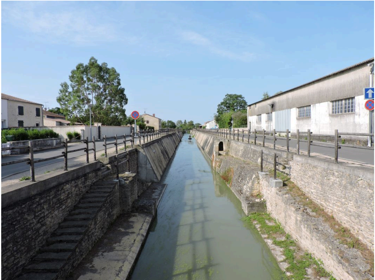
Le canal du Pont aux chèvres dans la traversée du village du même nom, vu en direction du sud-ouest.
