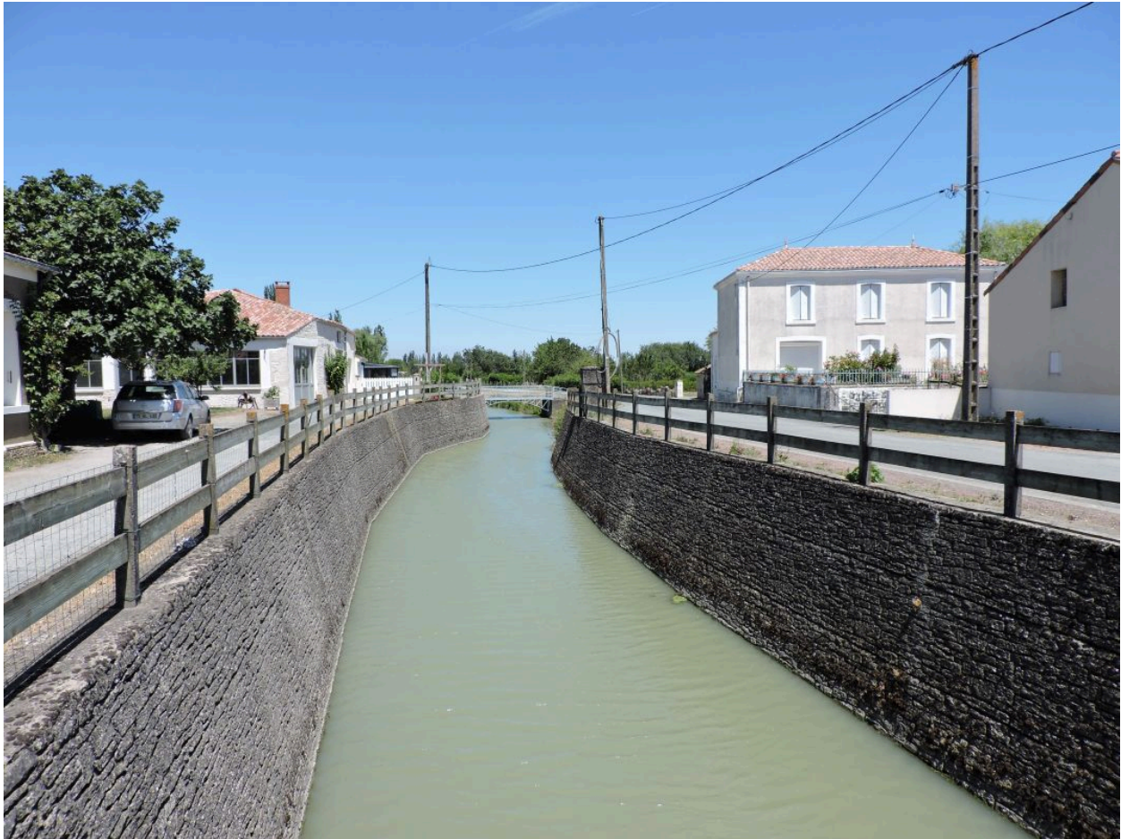
Le canal dans la traversée du village du Pont aux chèvres, en amont du pont, vu depuis celui-ci, en direction du nord-est.
