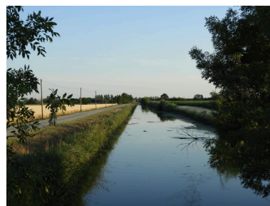
La partie amont du canal vue depuis le pont de Bois, en direction du sud-ouest. Phot. Yannis Suire IVR52_20198503598NUCA
