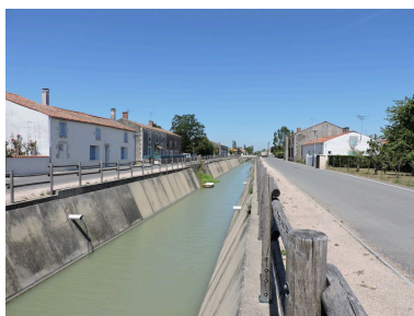
Le canal dans la traversée du village du Pont aux chèvres, vu depuis le sud-ouest.
