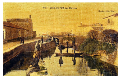
Le canal et les abreuvoirs sur sa rive gauche, en amont du pont, vers 1910. Phot. Yannis (reproduction) Suire IVR52_20198503809NUCA
