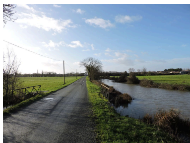
Le canal et son chemin de halage au nord du village du Pont aux chèvres, vu en direction du sud. Phot. Yannis Suire IVR52_20198503563NUCA
