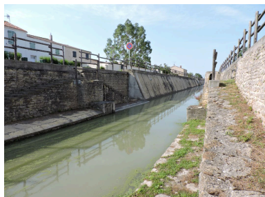
Les abords du canal, maçonnés, en aval du pont aux chèvres, en direction du sud.
