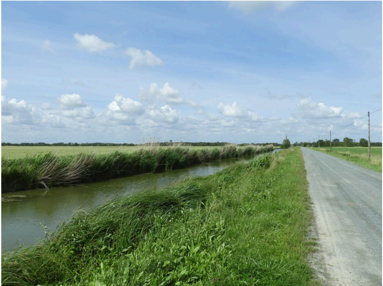
Le canal et son chemin de halage au nord du village du Pont aux chèvres, vu en direction du nord.
