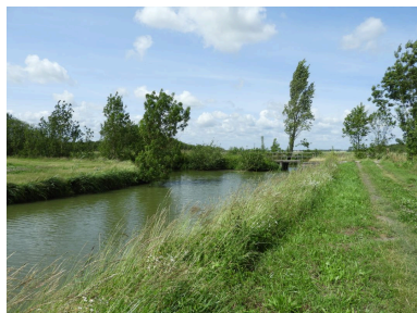
Le départ du canal, au Tapecul. Phot. Yannis Suire IVR52_20198503508NUCA
