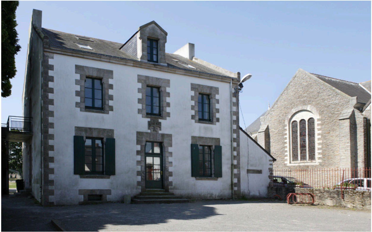
Vue de la façade nord.
