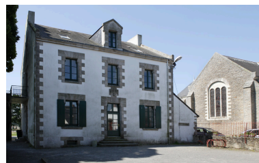
Vue de la façade nord. Phot. Denis Pillet IVR52_20084401851NUCA
