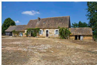
Logis avec fournil à gauche et porcheries à droite. Phot. Yves Guillotin IVR52_20107202368NUCA
