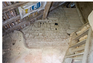
Logis, essentage de bardeaux de l'ancien pignon sud du logis. Phot. Yves Guillotin IVR52_20107202348NUCA
