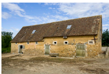
Étables-fenil. Phot. Yves Guillotin IVR52_20107202412NUCA
