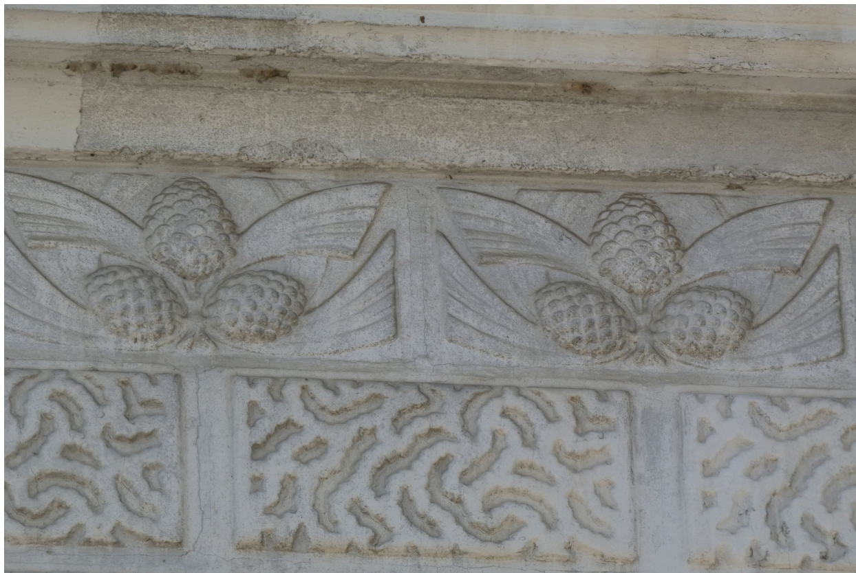
Détail du parement : pommes de pin et bossage vermiculé.
