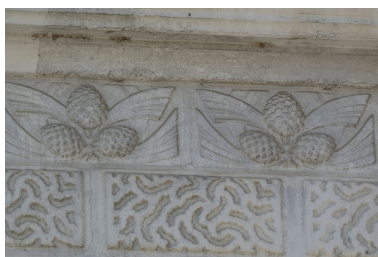
Détail du parement : pommes de pin et bossage vermiculé. Phot. Yannis Suire IVR52_20238501427NUCA
