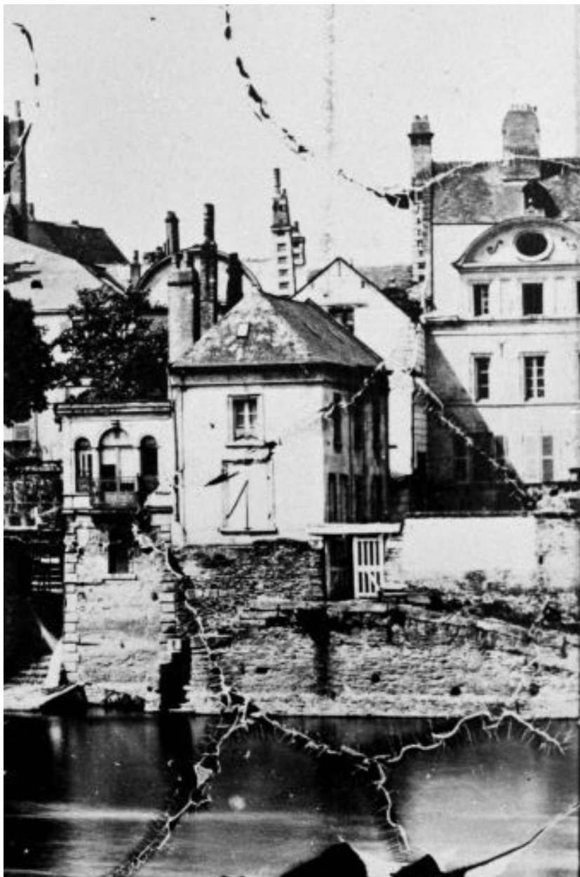
Partie d'élévation du grenier à sel ouvrant sur la Maine, fotogr., [années 1860].
