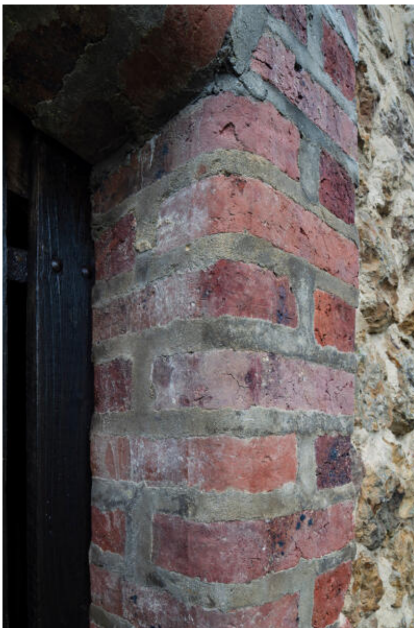
Cellier : détail de la porte extérieure.
