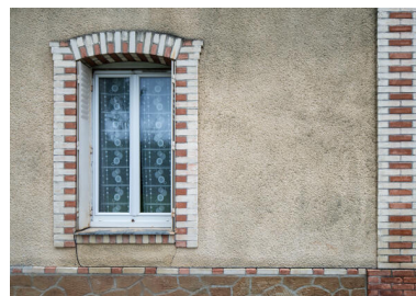
Logis : détail de mise en oeuvre. Phot. Thierry Seldubuisson IVR52_20247200418NUCA
