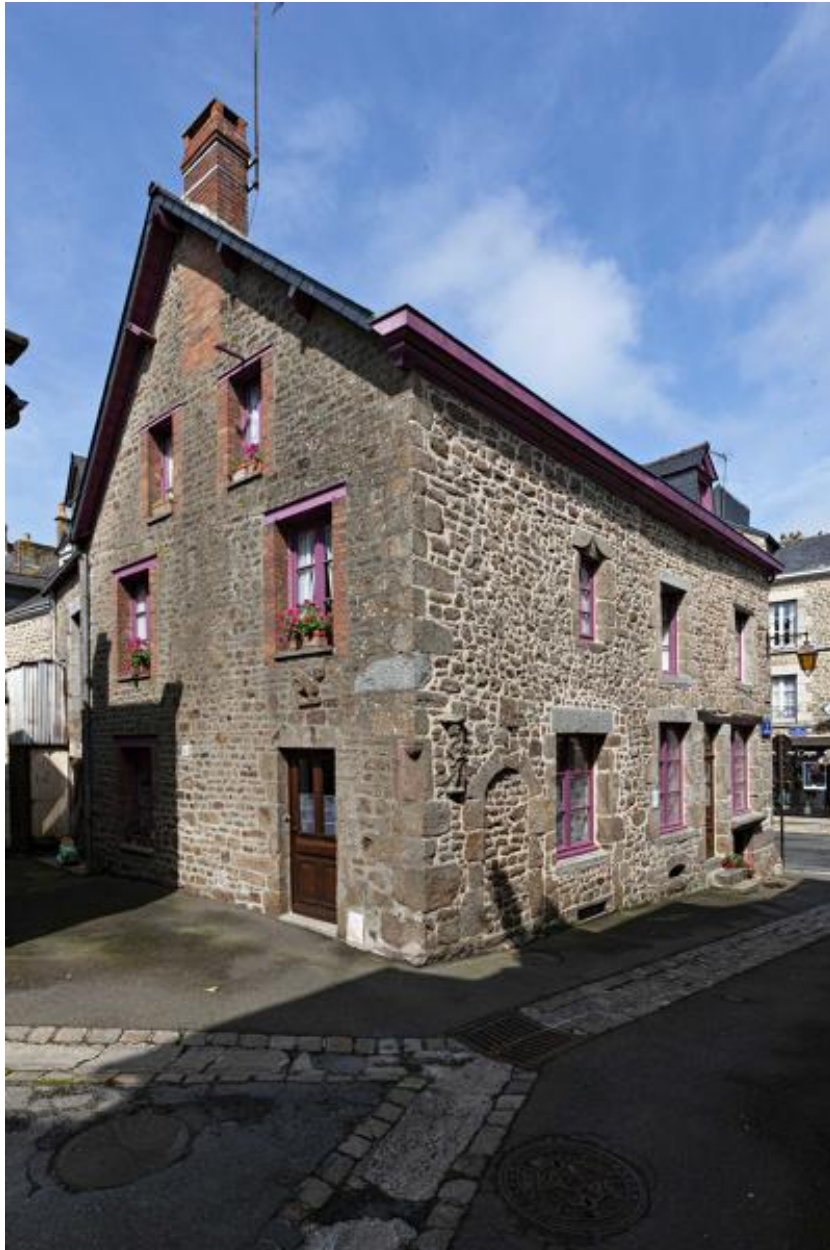
Maison, 2 rue du Haut-Perrin.
