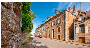
Bloc de maisons de la rue de Domfront. Phot. Pierre-Bernard Fourny IVR52_20235300818NUCA
