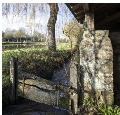
Lavoir sur le Lassay, sous le 18 rue du Château. Phot. Yves Guillotin IVR52_20225300012NUCA
