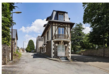
Maison du 2 chemin de la Loge. Phot. Yves Guillotin IVR52_20215300770NUCA
