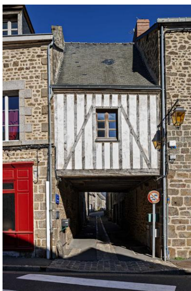
Porche en pan de bois, au- dessus de la rue Cébaudière. Phot. Yves Guillotin IVR52_20215301812NUCA
