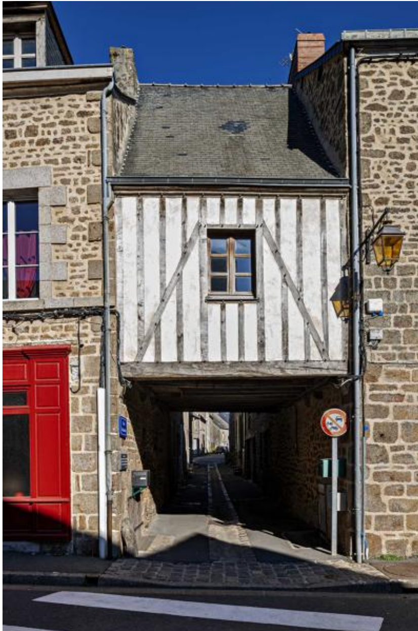
Porche en pan de bois, au-dessus de la rue Cébaudière.
