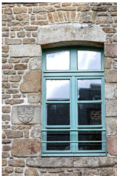
Façade du 5 Grande-Rue, écu portant le millésime 1614 en remploi dans le piédroit de la fenêtre de l'étage carré. Phot. Yves Guillotin IVR52_20215300791NUCA
