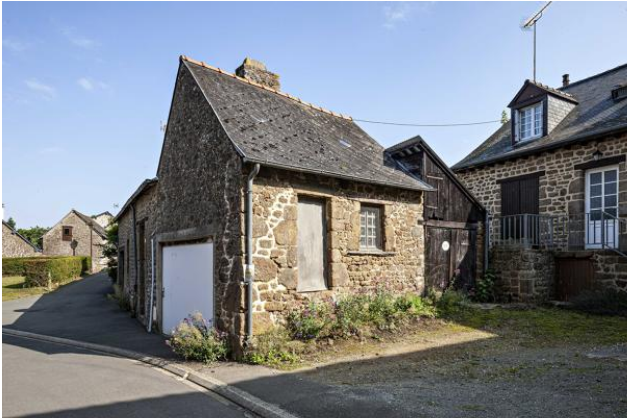
Fournil, rue des jardins, linteau portant le millésime 1764.
