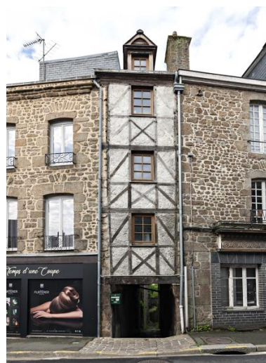
Porche en pan de bois surmontant la ruelle du Crotton. Phot. Yves Guillotin IVR52_20195301147NUCA
