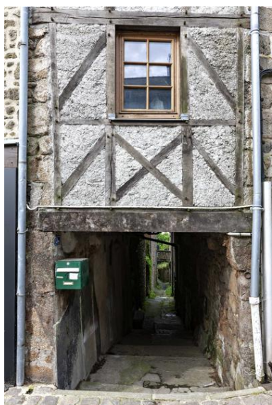
Porche en pan de bois surmontant la ruelle du Crotton. Phot. Yves Guillotin IVR52_20195301148NUCA
