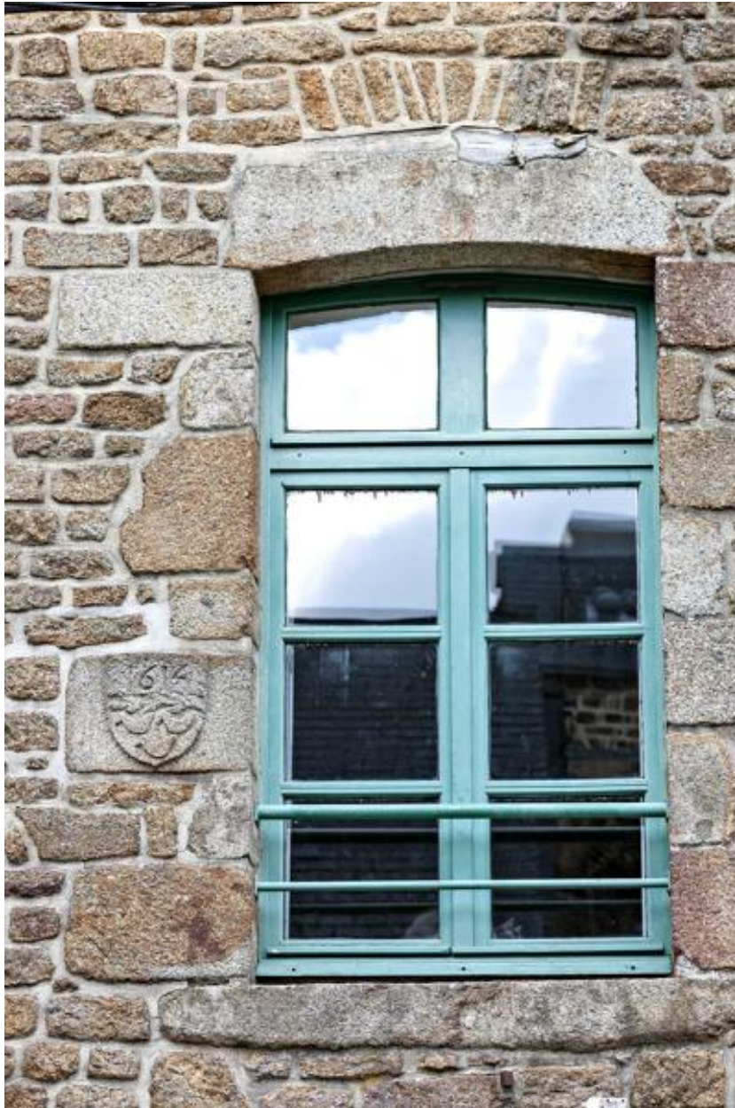
Façade du 5 Grande-Rue, écu portant le millésime 1614 en remploi dans le piédroit de la fenêtre de l'étage carré.
