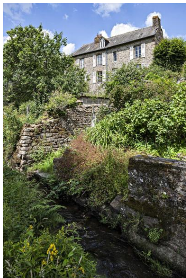
Flanc sud du bourg, rivière du Lassay, maison à l'arrière de la parcelle du 6, place du 8-Mai-1945. Phot. Yves Guillotin IVR52_20215300793NUCA
