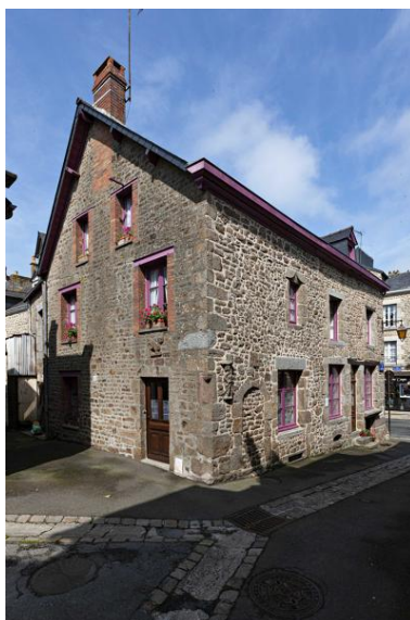
Maison, 2 rue du Haut-Perrin. Phot. Yves Guillotin IVR52_20195301170NUCA
