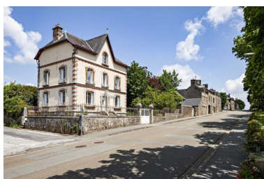
Maison du 7 place du Champ-de-Foire. Phot. Yves Guillotin IVR52_20215300767NUCA
