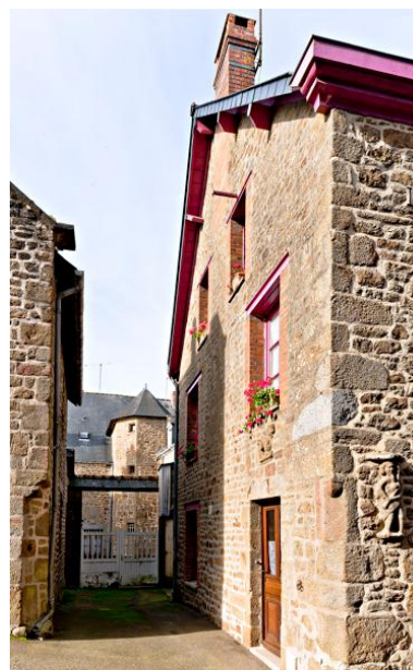
Maison 2, rue du Haut-Perrin, devant le manoir du Haut Perrin. Phot. Yves Guillotin IVR52_20175300205NUCA
