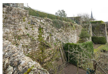
Flanc sud du bourg, murs des jardins surmontant le Lassay, sous la maison du 20 place du 8-Mai-1945. Phot. Yves Guillotin IVR52_20225300072NUCA
