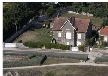
Elévation sur mer. Phot. Denis Pillet IVR52_20114401128NUCA
