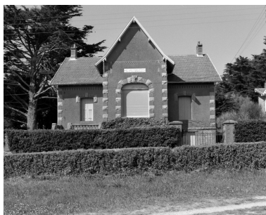
Elévation côté mer. Phot. Denis Pillet IVR52_19974401112X
