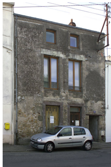
Vue de la façade antérieure. Phot. Denis Pillet IVR52_20044401918NUCA
