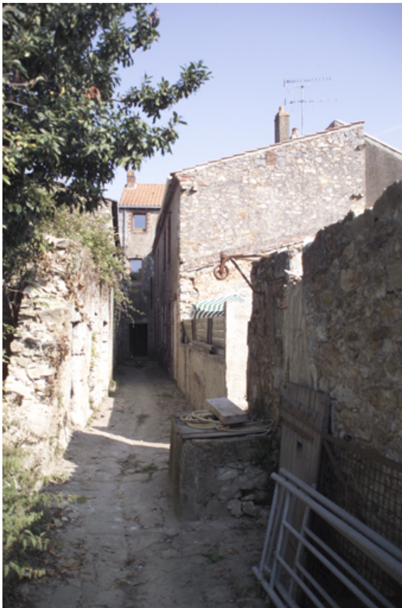
Vue de la ruelle depuis le sud vers la rue.
