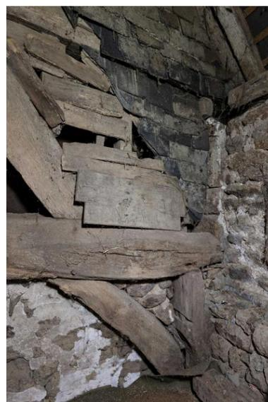
Ferme de charpente entre le comble de la maison et celui du cellier, détail de l'assemblage poteau sud, entrait, lien, arbalétrier.
