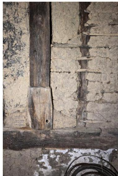
Ferme de charpente entre le comble de la maison et celui du cellier, détail du poinçon.
