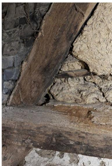
Ferme de charpente entre le comble de la maison et celui du cellier, détail du remplissage de torchis.
