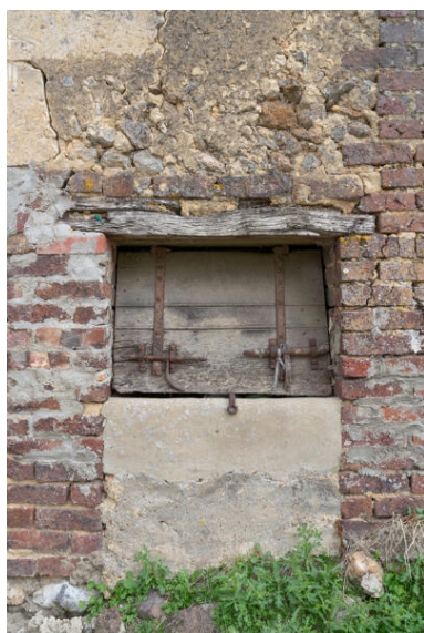
Étables : trappe pour nourrir les cochons. Phot. Jeanne Minier IVR52_20257200452NUCA
