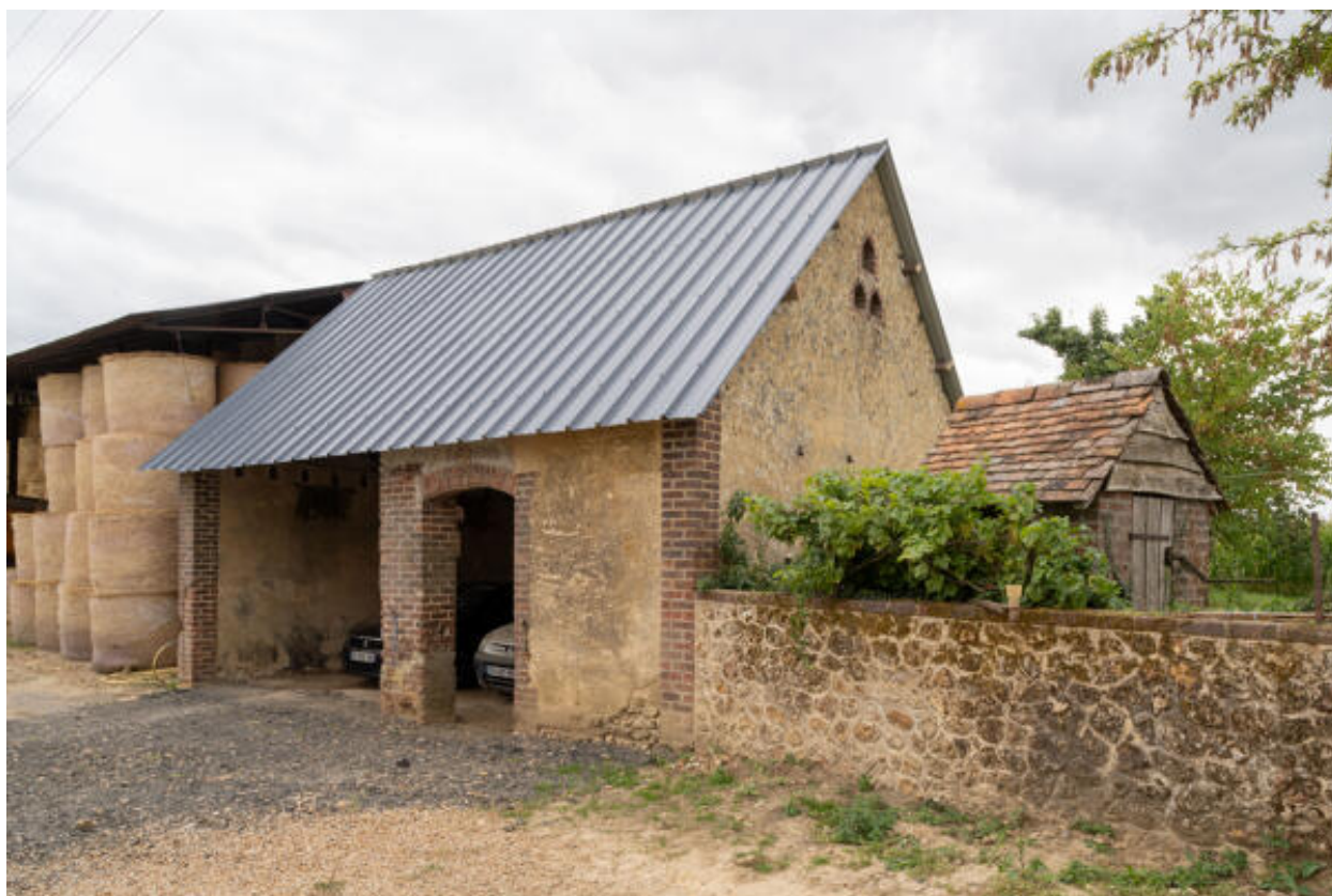
Hangar et puits.
