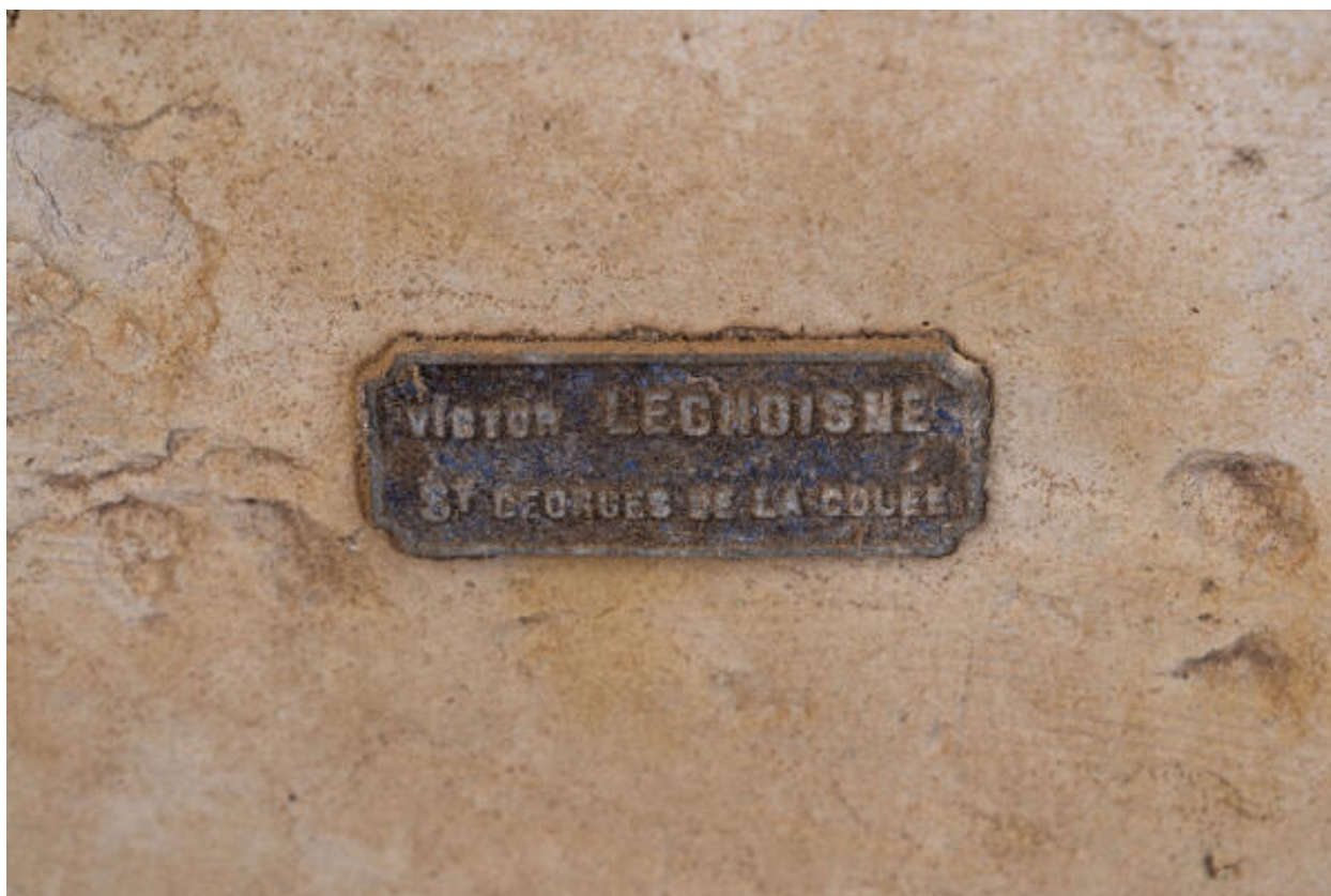
Cellier semi-enterré : marque de maçon.
