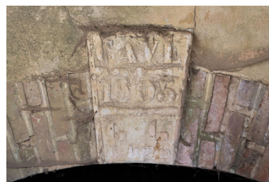
Cellier semi-enterré : date et inscription portée sur la clef de la porte. Phot. Jeanne Minier IVR52_20257200458NUCA
