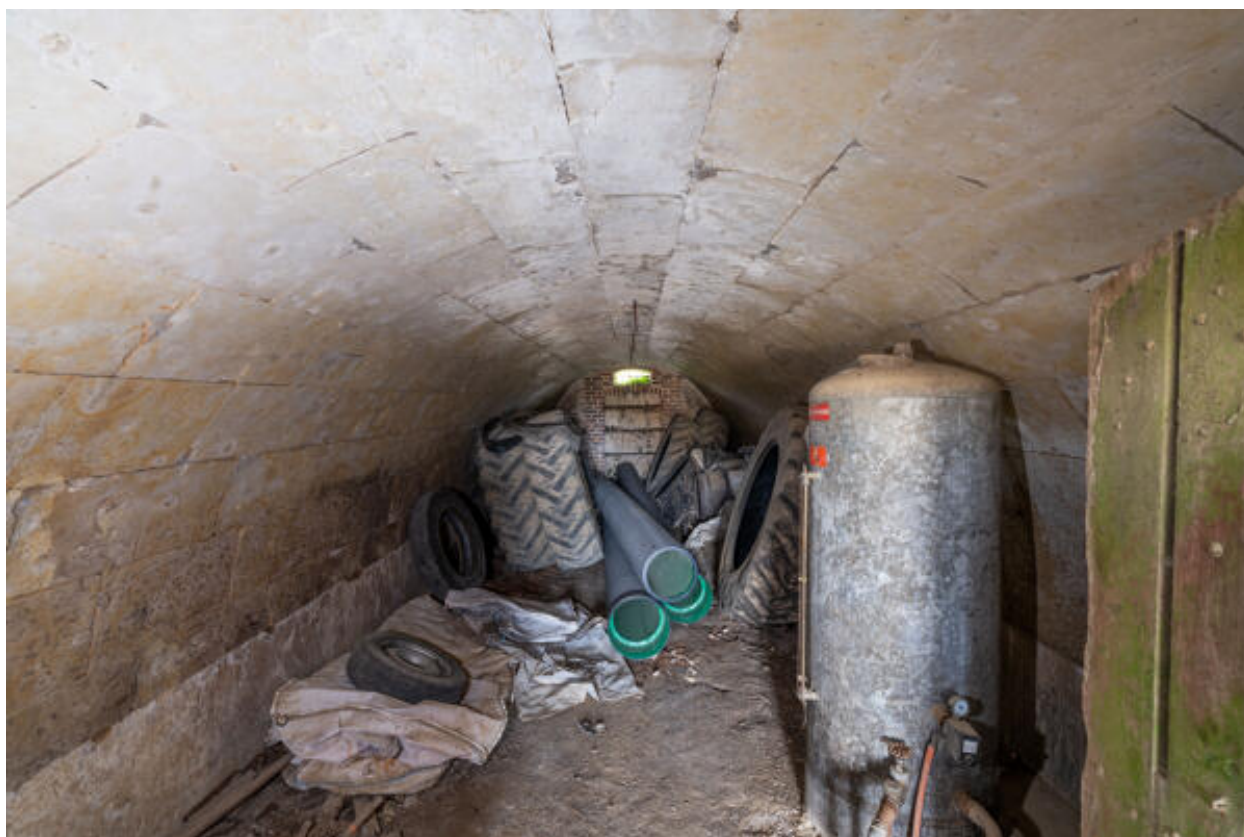
Cellier semi-enterré : vue intérieure.
