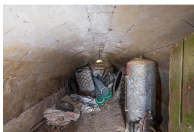
Cellier semi-enterré : vue intérieure. Phot. Jeanne Minier IVR52_20257200459NUCA
