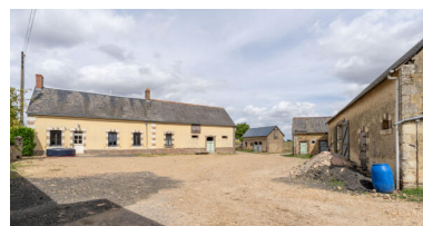
La cour, vue depuis le sud : à gauche, logis et grange-étable sous même faîte ; au fond, les étables dissociées ; à droite, la grange-étable dissociée. Phot. Jeanne Minier IVR52_20257200443NUCA
