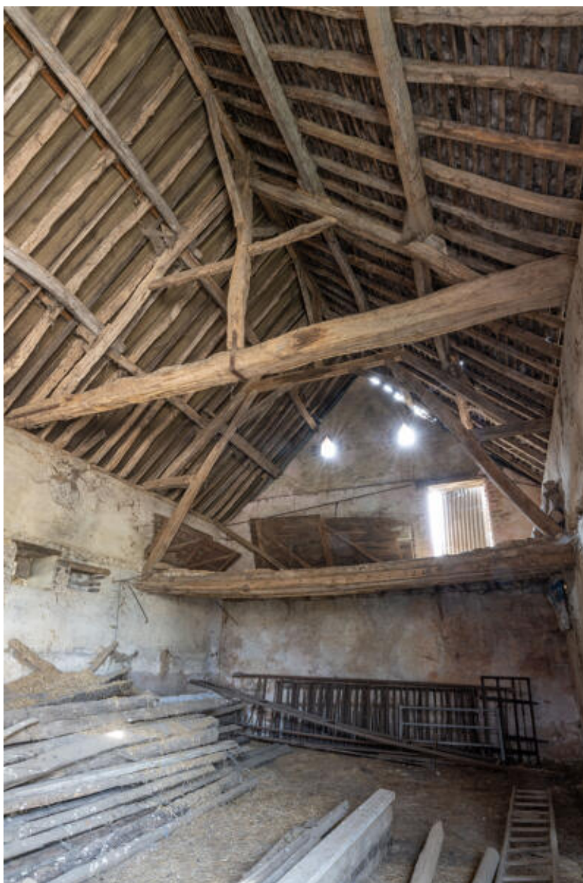
Grange-étable dissociée : charpente.
