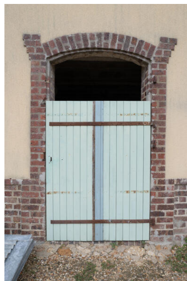
Grange-étable associée : porte d'étable. Phot. Jeanne Minier IVR52_20257200450NUCA
