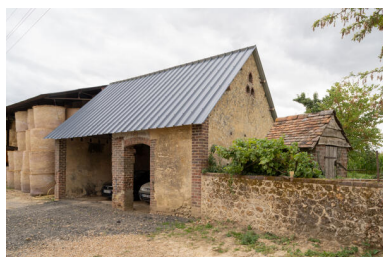
Hangar et puits. Phot. Jeanne Minier IVR52_20257200456NUCA
