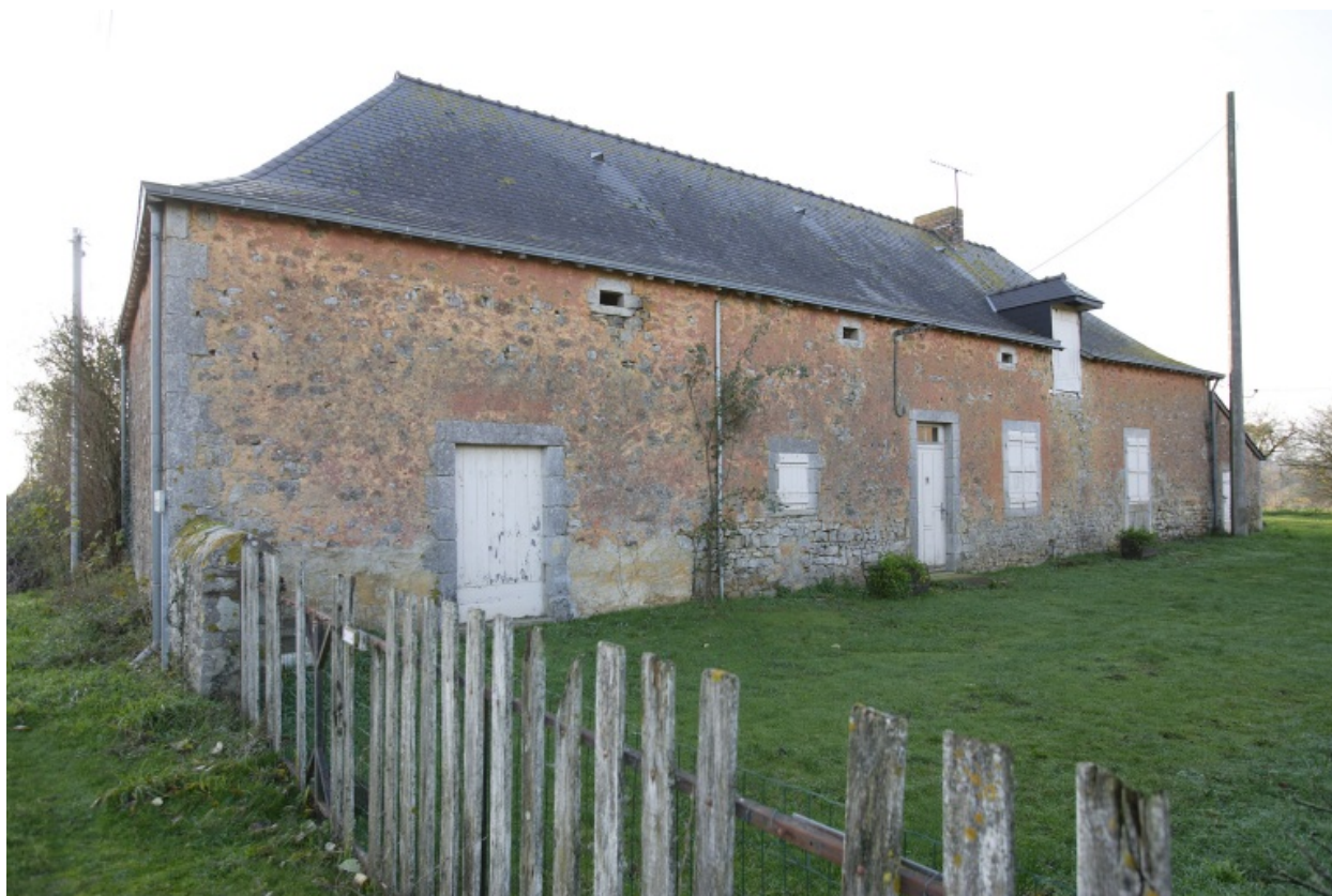
Le logis vu depuis le nord-est.
