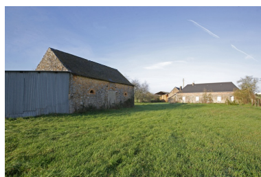
La remise et le logis vus depuis le sud. Phot. François Lasa
