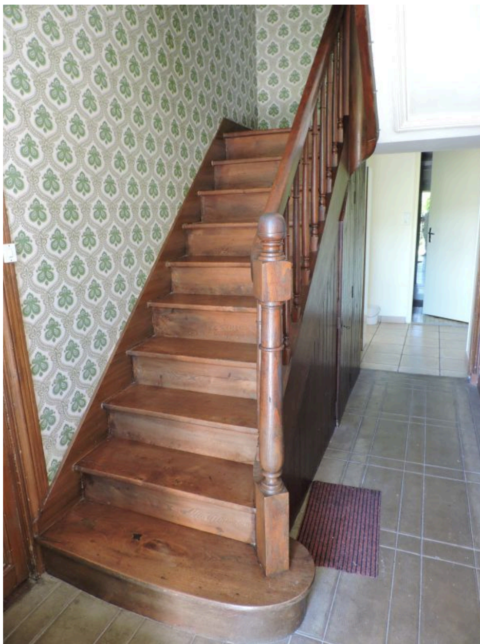
L'escalier en bois dans le corridor central.
