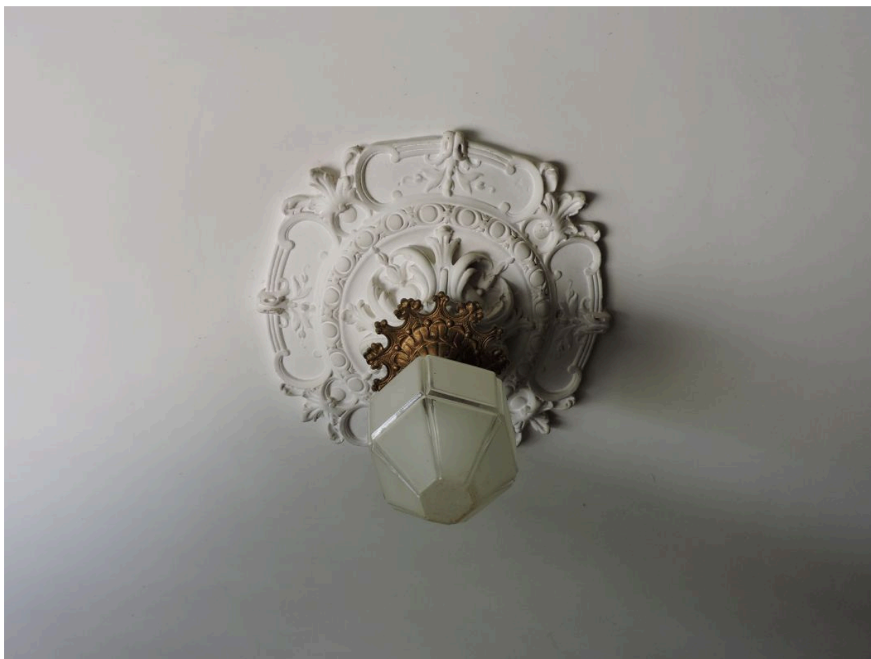
Exemple de décor mouluré au rez-de-chaussée.
