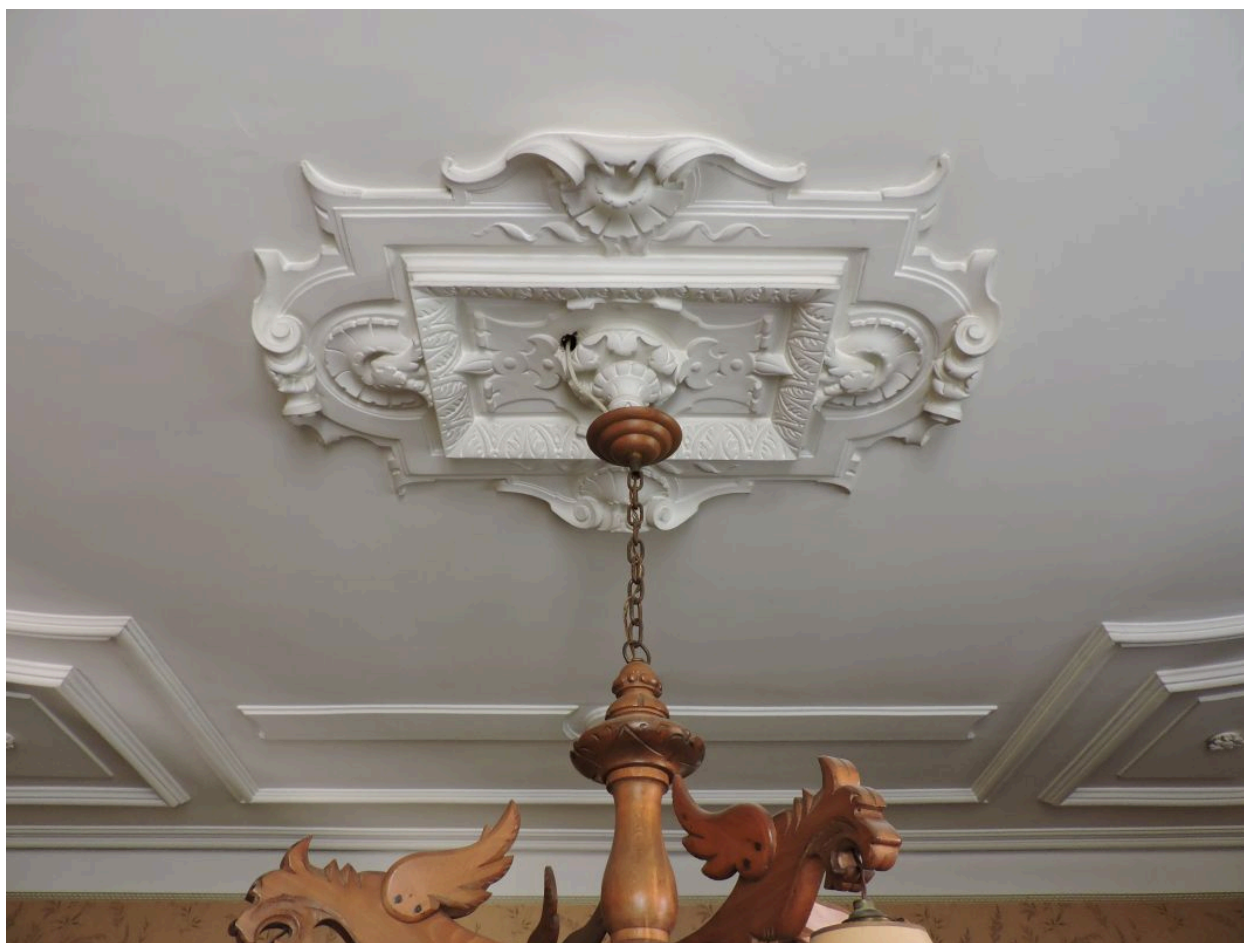
Exemple de décor mouluré au rez-de-chaussée.
