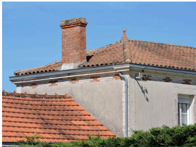
Détail : fris en briques rouges et blanches soulignant le toit à croupes. Phot. Yannis Suire IVR52_20198501533NUCA
