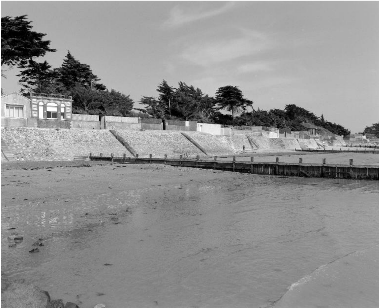
Vue de l'ensemble des perrés du quartiers des Carrés.
