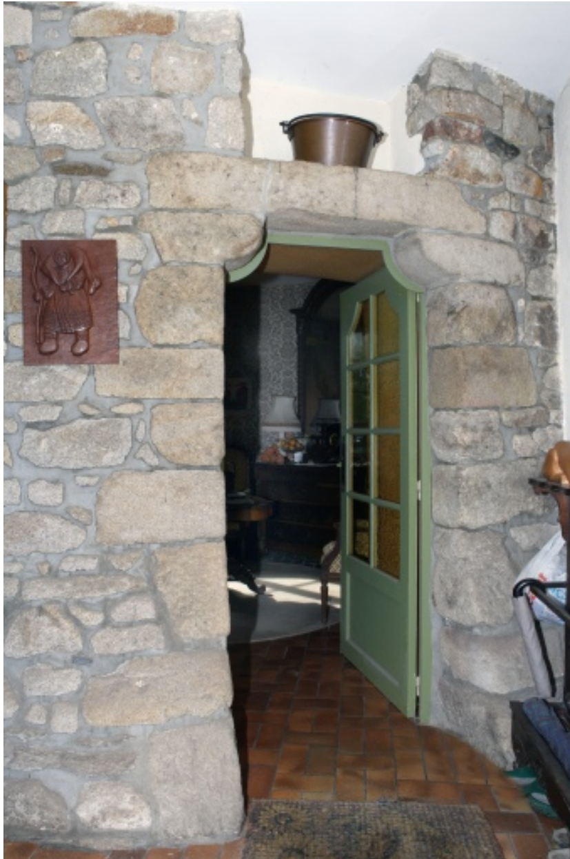
Pied de la tour englobé dans une maison accolée à l'est de l'édifice. Détail de la porte est.
