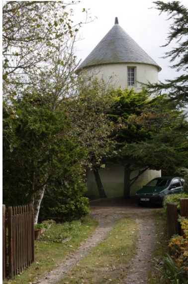
Vue d'ensemble depuis le nord. Phot. Denis Pillet IVR52_20074401267NUCA
