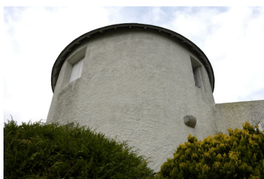
Partie supérieure de la tour vue depuis le sud. À droite, l'un des corbeaux subsistant, qui servaient à supporter l'axe du treuil permettant de hisser les sacs de blé.
