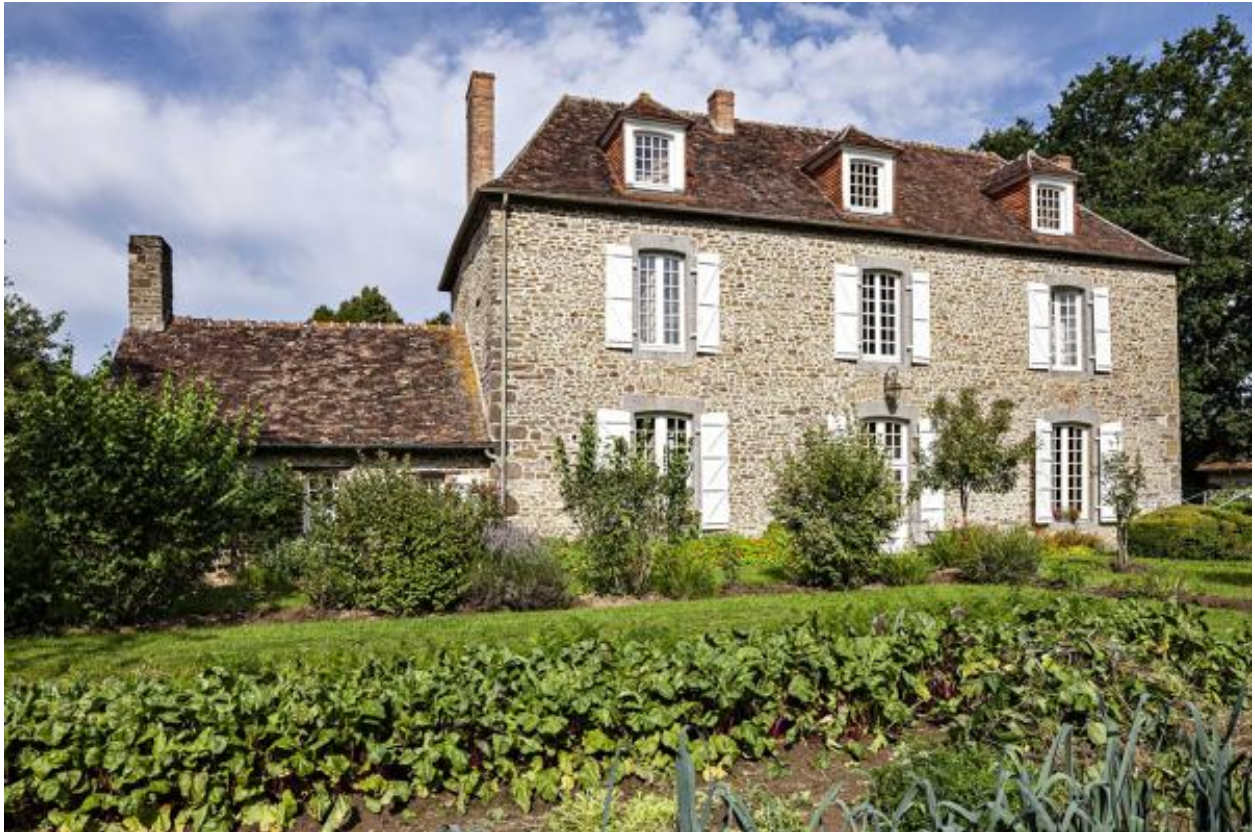
Façade sud, logis et fournil.
