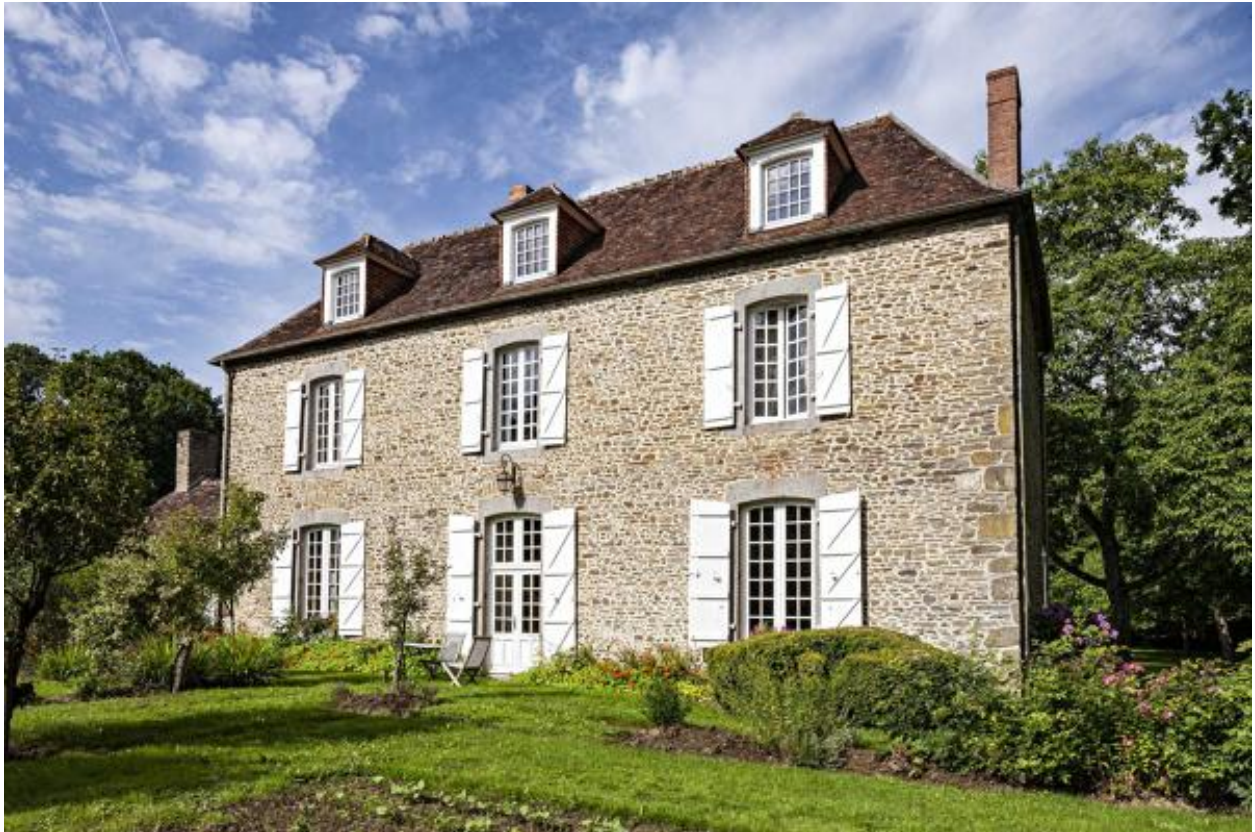
Façade sud, vue de trois-quarts.
