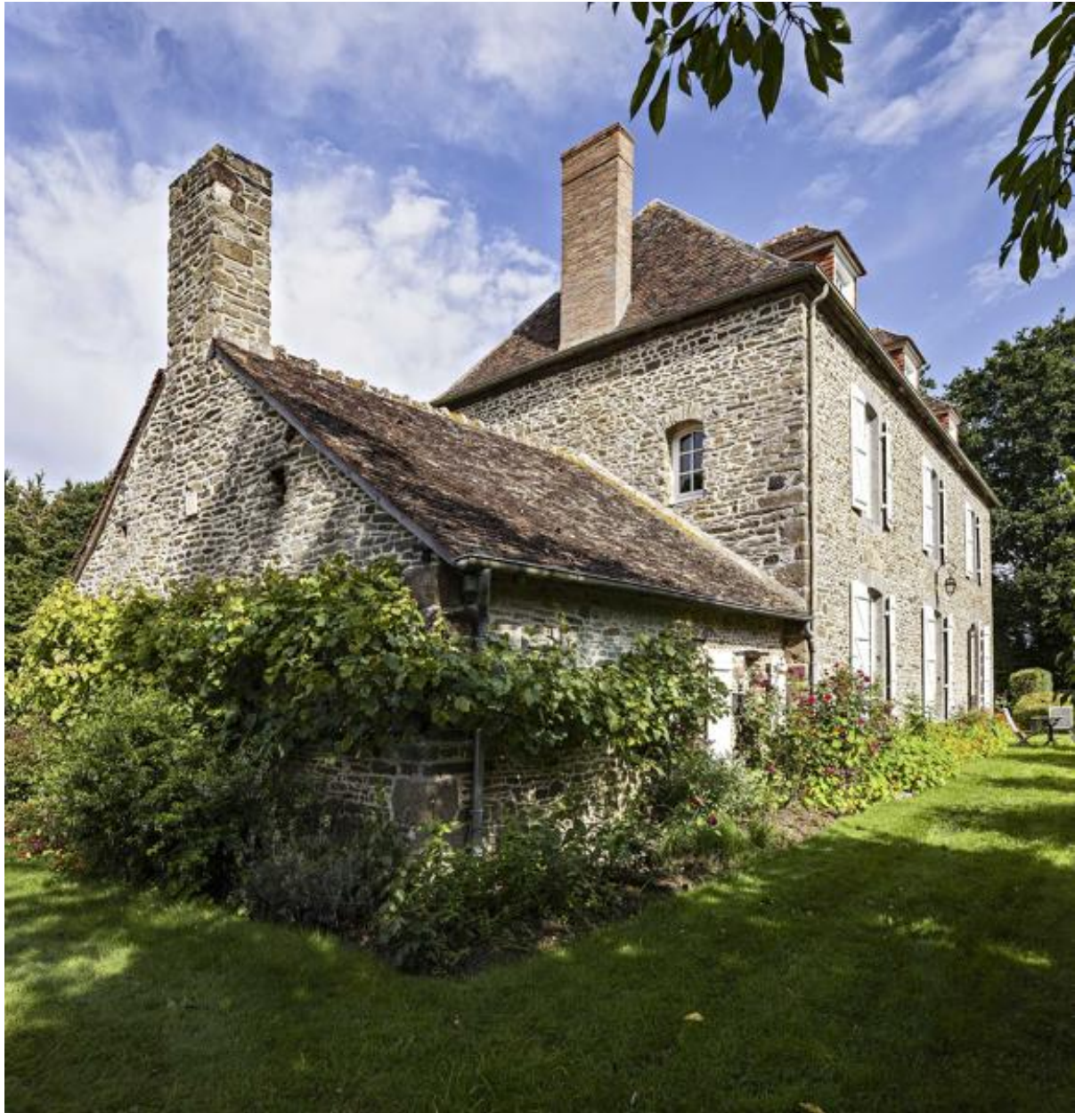
Façade sud, logis et fournil.
