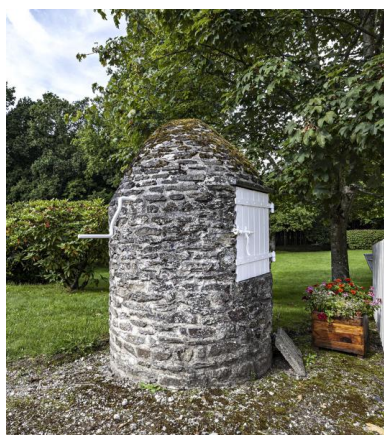
Puits couvert. Phot. Yves Guillotin IVR52_20215300861NUCA
