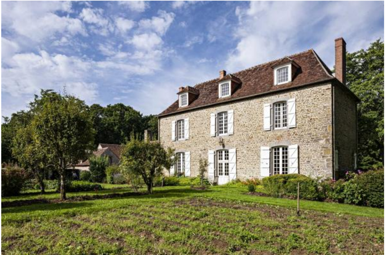
Façade sud, vue de trois-quarts.
