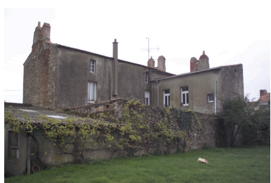
La façade postérieure vue depuis le jardin de la maison n° 5 rue Saint-Gilles. Phot. Denis Pillet IVR52_20034401931NUCA
