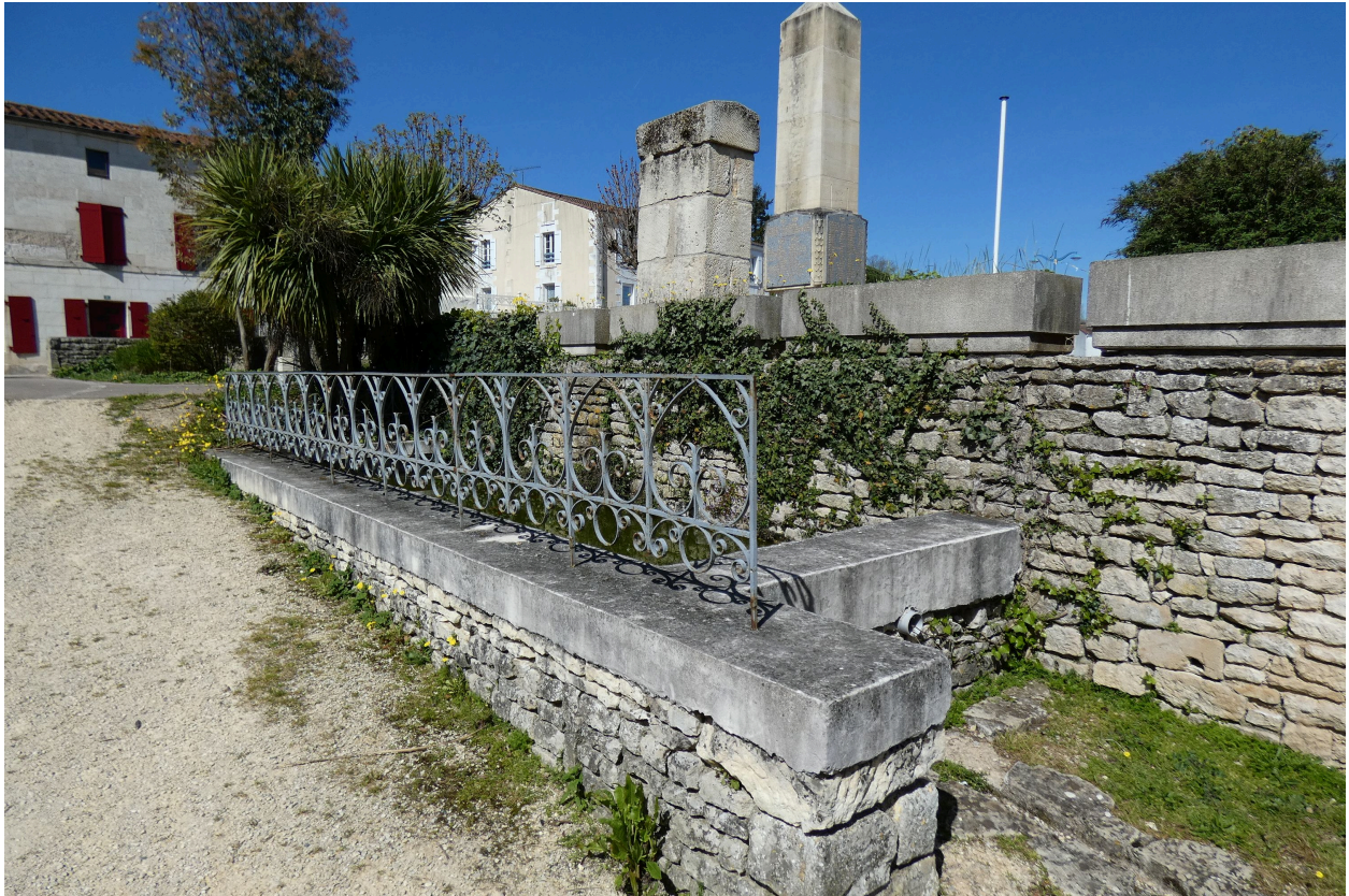
Le bassin à l'arrière de la pompe, vu depuis le sud.
