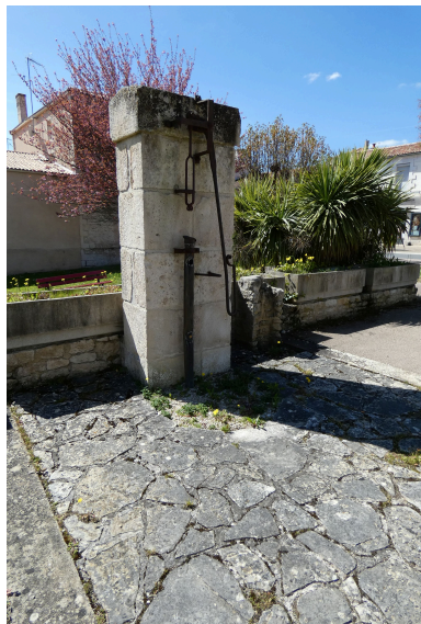
La pompe vue depuis l'est. Phot. Yannis Suire IVR52_20238501276NUCA
