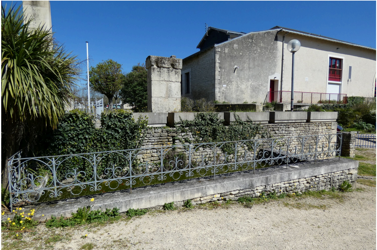
Le bassin à l'arrière de la pompe, vu depuis l'ouest.
