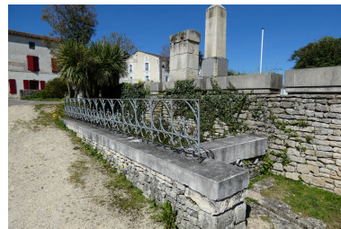
Le bassin à l'arrière de la pompe, vu depuis le sud. Phot. Yannis Suire IVR52_20238501277NUCA
