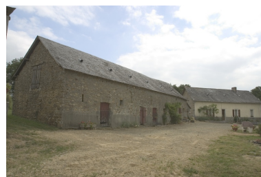
Vue d'ensemble depuis l'ouest : l'ancien logis-étable et le logis actuel. Phot. François Lasa IVR52_20045302033NUCA
