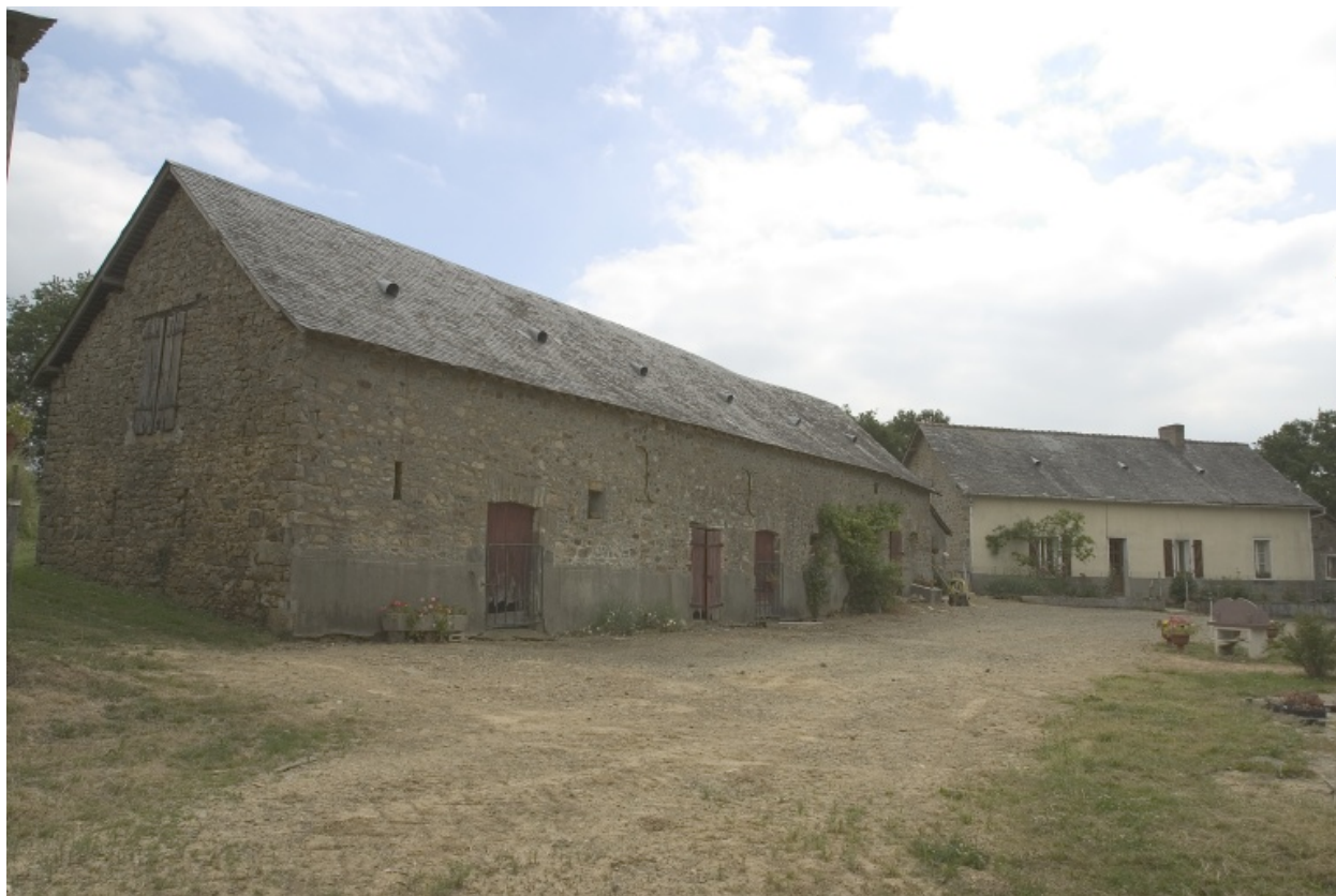
Vue d'ensemble depuis l'ouest : l'ancien logis-étable et le logis actuel.
