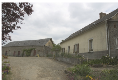
Vue d'ensemble depuis l'entrée au sud : l'ancien logis-étable et l'actuel logis. Phot. François Lasa
