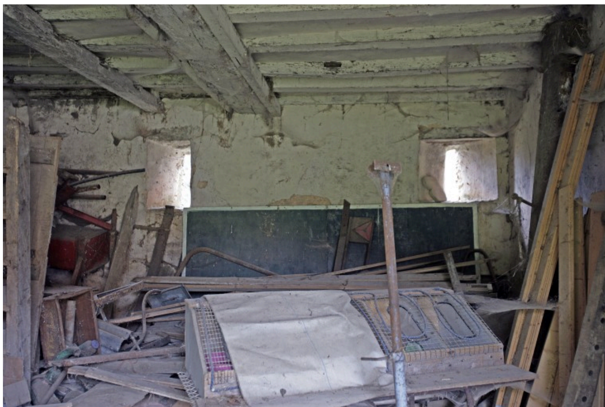
Étables à chevaux, vue intérieure : meurtrières ?
