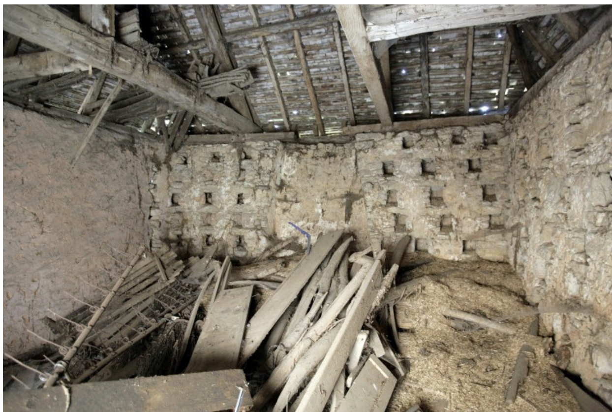
Colombier : vue intérieure de l'étage de comble.
