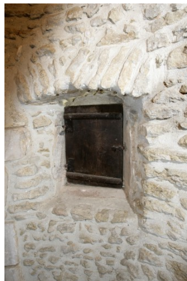
Logis, intérieur : baie de l'escalier. Phot. François Lasa IVR52_20077200615NUCA
