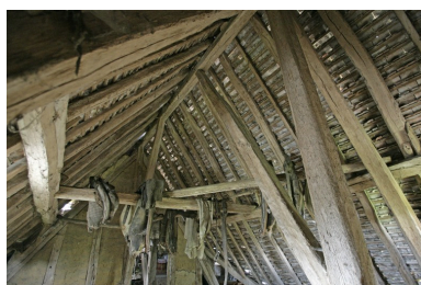
Logis, charpente de l'aile en retour. À noter la présence d'un faux-entrait intermédiaire. Phot. François Lasa IVR52_20077200614NUCA
