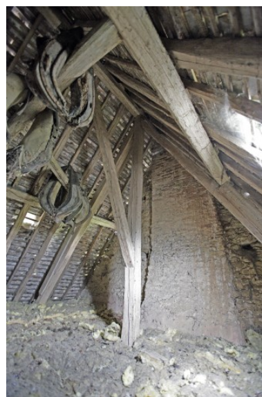
Logis, charpente de l'aile en retour : vue depuis le faux-entrait intermédiaire. Phot. François Lasa IVR52_20077200612NUCA
