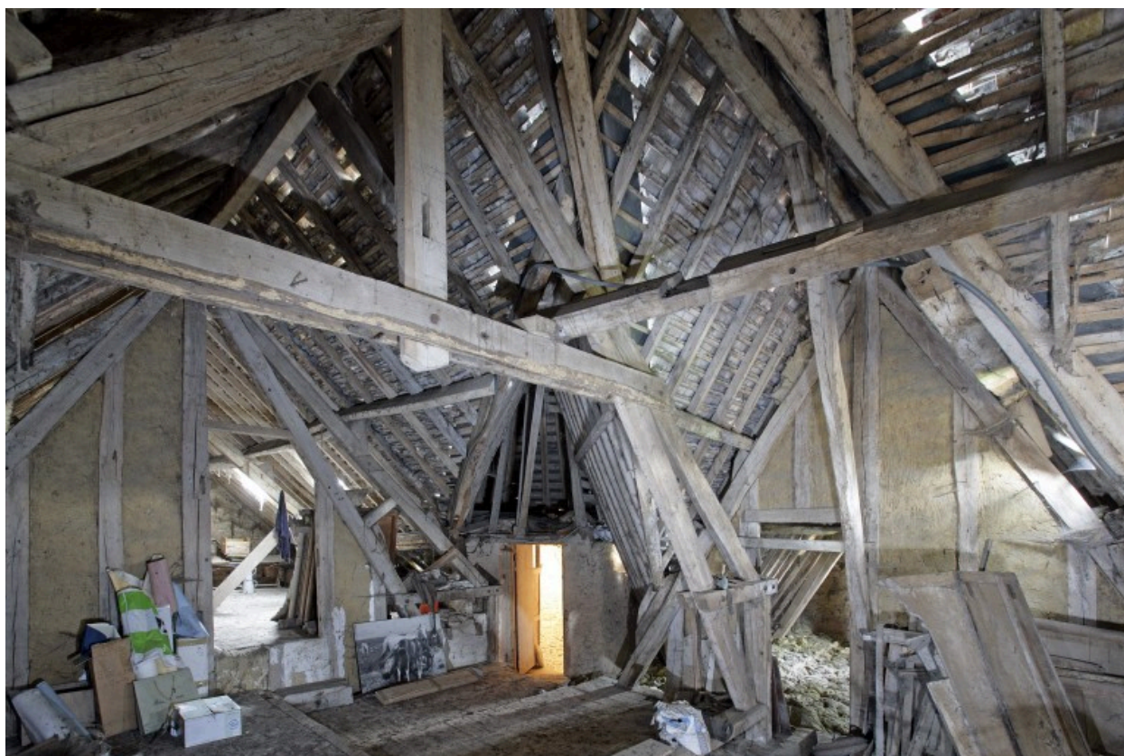
Logis, charpentes, vue générale : au centre, accès depuis la tour d'escalier ; à droite, ferme de charpente de l'aile en retour ; à gauche, ferme de charpente de l'aile sur cour.
