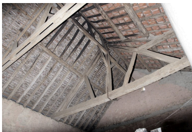
Grange, vestige de la charpente ancienne : ferme et contreventement longitudinal. Phot. François Lasa IVR52_20077200640NUCA
