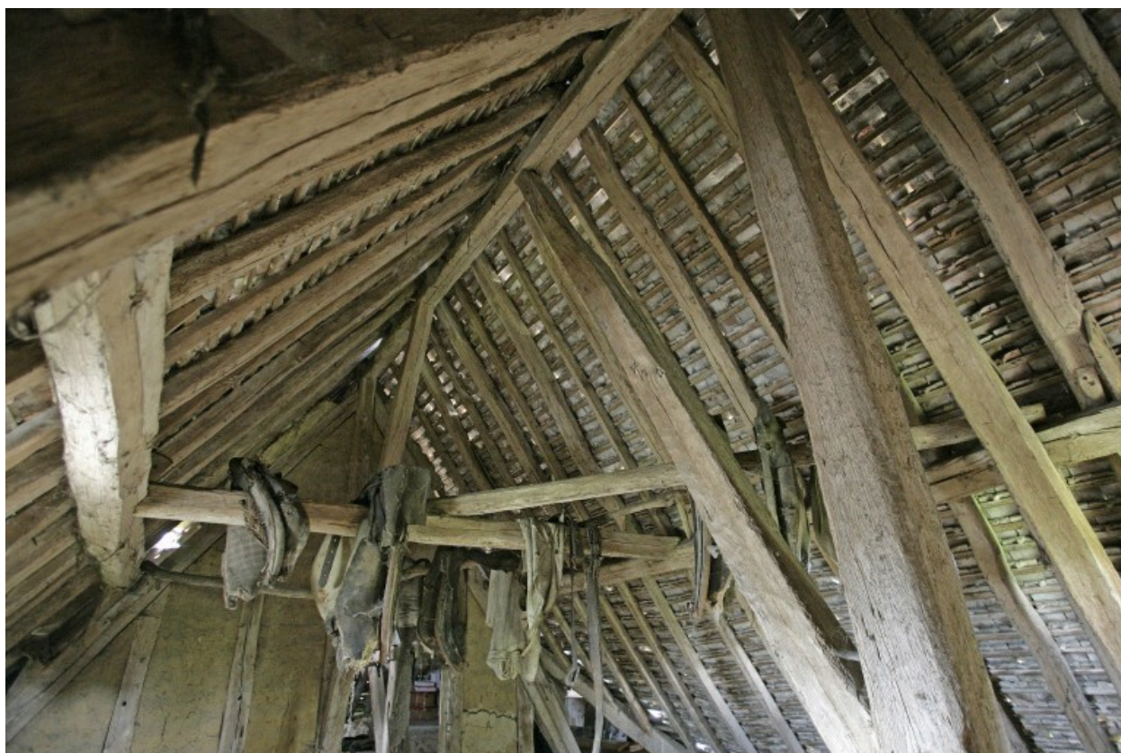
Logis, charpente de l'aile en retour. À noter la présence d'un faux-entrait intermédiaire.
