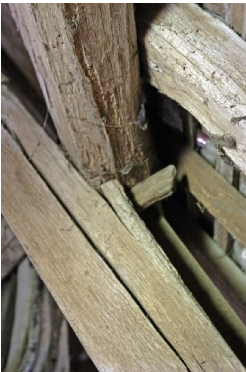
Logis, charpente de l'aile en retour : détail de la jonction entre arbalétrier et panne.
