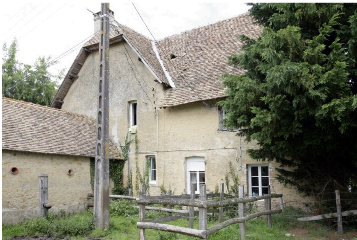
Logis, élévation sud avec vestige d'une demi-croisée.
