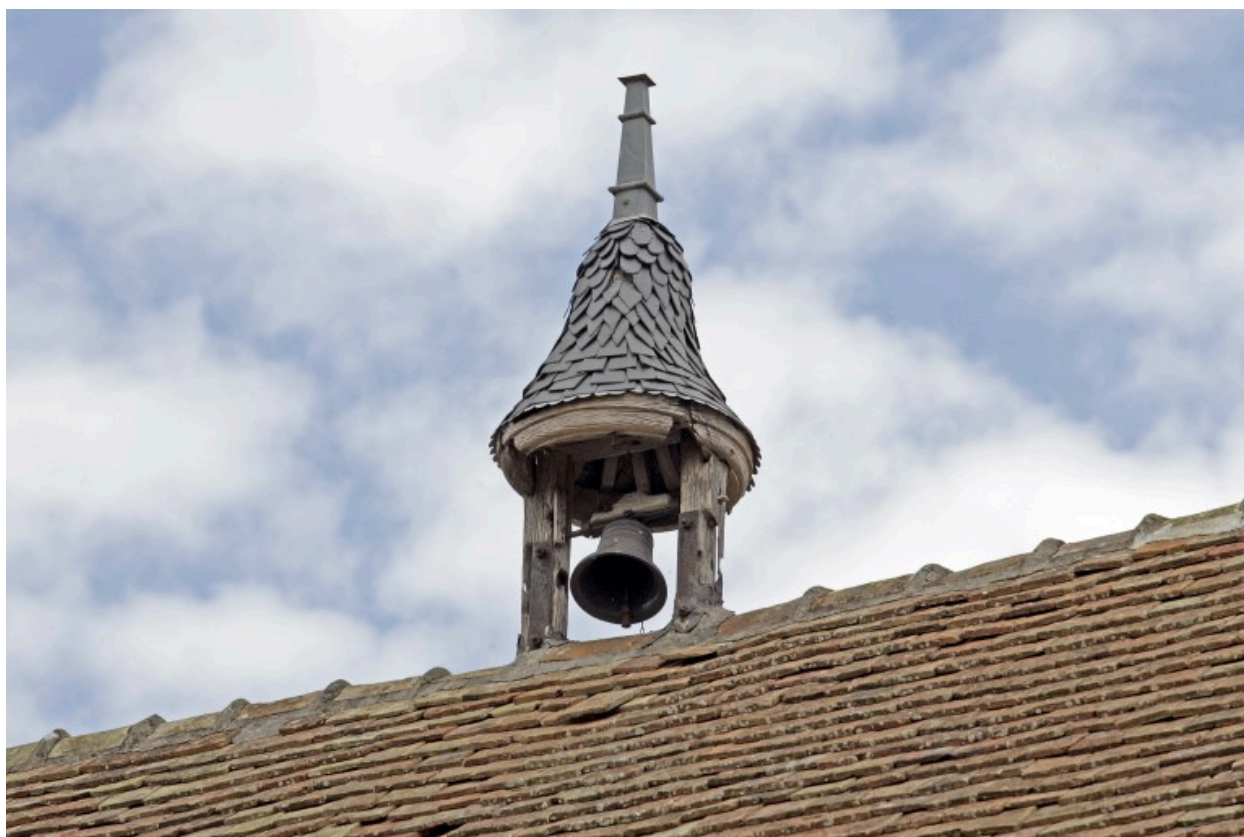
Logis : campanile provenant de la tuilerie de Saint-Aignan.
