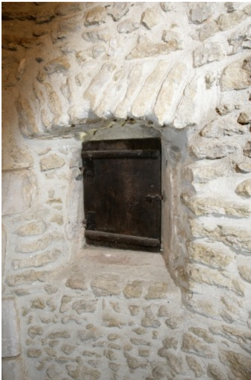
Logis, intérieur : baie de l'escalier.
