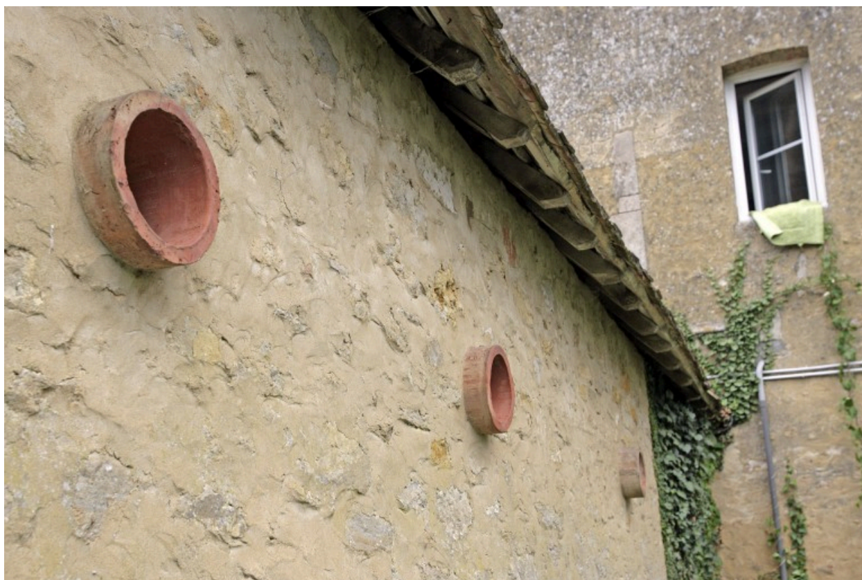
Porcheries, élévation postérieure : détail du système de ventilation.
