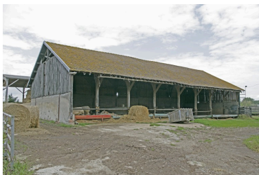
Halle de la tuilerie de Saint-Aignan remontée comme hangar agricole. Phot. François Lasa IVR52_20077200639NUCA
