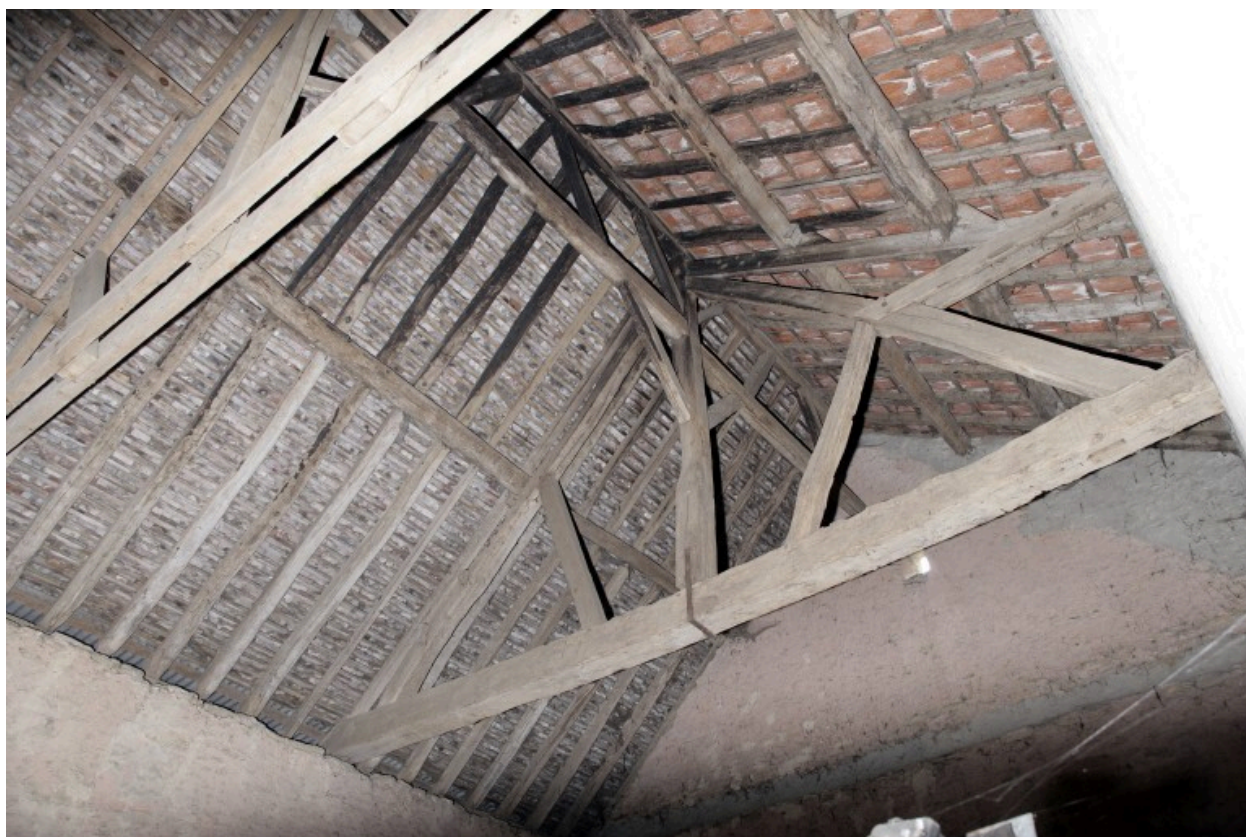
Grange, vestige de la charpente ancienne : ferme et contreventement longitudinal.
