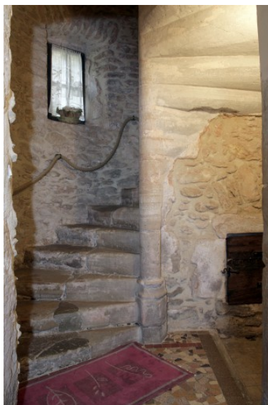
Logis, intérieur : escalier en vis vu du rez-de-chaussée. Phot. François Lasa IVR52_20077200604NUCA
