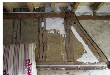
Logis, intérieur : détail d'une ferme de charpente du corps principal du logis, marquant le niveau de l'ancien étage en surcroît.
