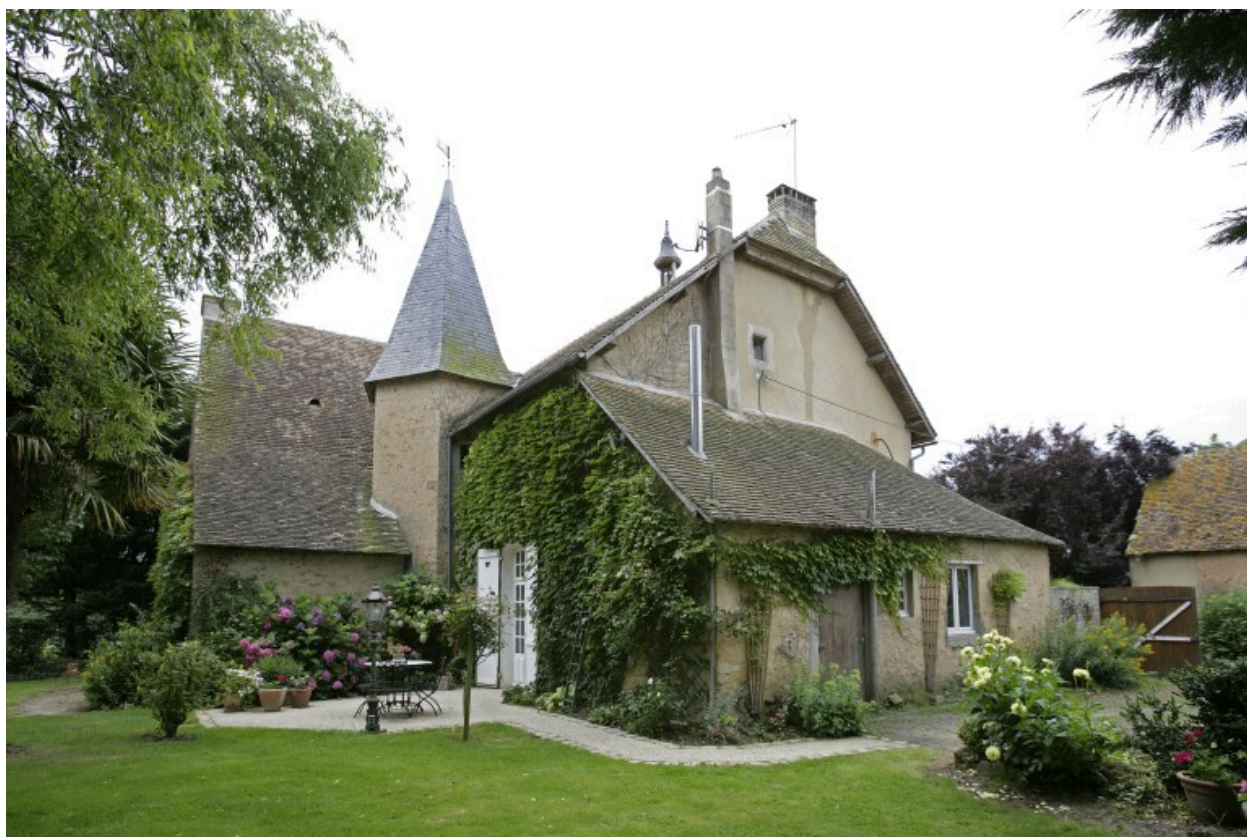
Logis : élévations postérieures et tourelle d'escalier.
