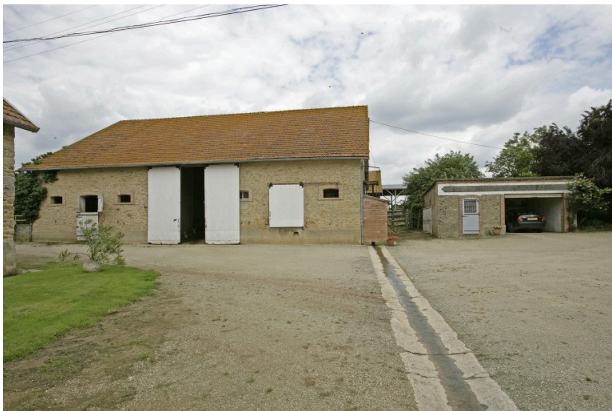
Grange et garage : élévation sur cour.
