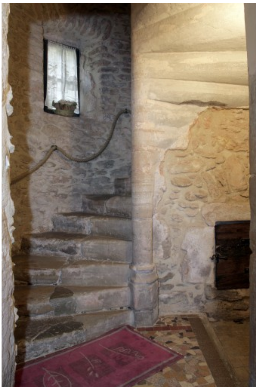
Logis, intérieur : escalier en vis vu du rez-de-chaussée.
