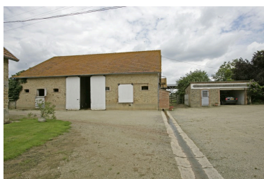
Grange et garage : élévation sur cour. Phot. François Lasa IVR52_20077200619NUCA
