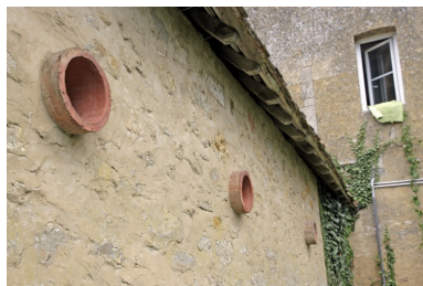
Porcheries, élévation postérieure : détail du système de ventilation. Phot. François Lasa IVR52_20077200630NUCA
