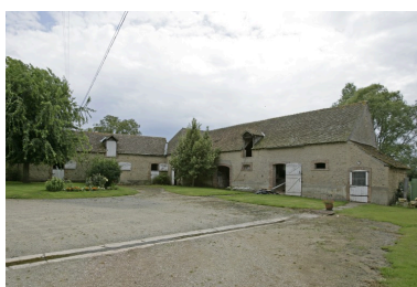
Porcherie, atelier et étables à chevaux : élévations sur cour. Phot. François Lasa IVR52_20077200618NUCA
