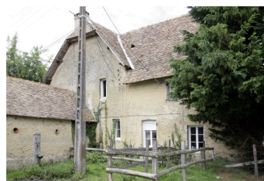
Logis, élévation sud avec vestige d'une demi-croisée. Phot. François Lasa IVR52_20077200628NUCA
