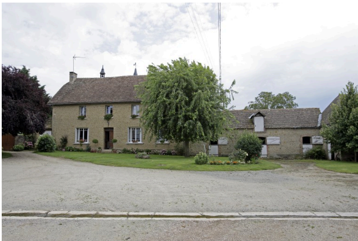
Logis et porcheries : élévations sur la cour.
