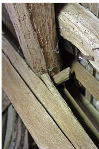
Logis, charpente de l'aile en retour : détail de la jonction entre arbalétrier et panne. Phot. François Lasa IVR52_20077200613NUCA
