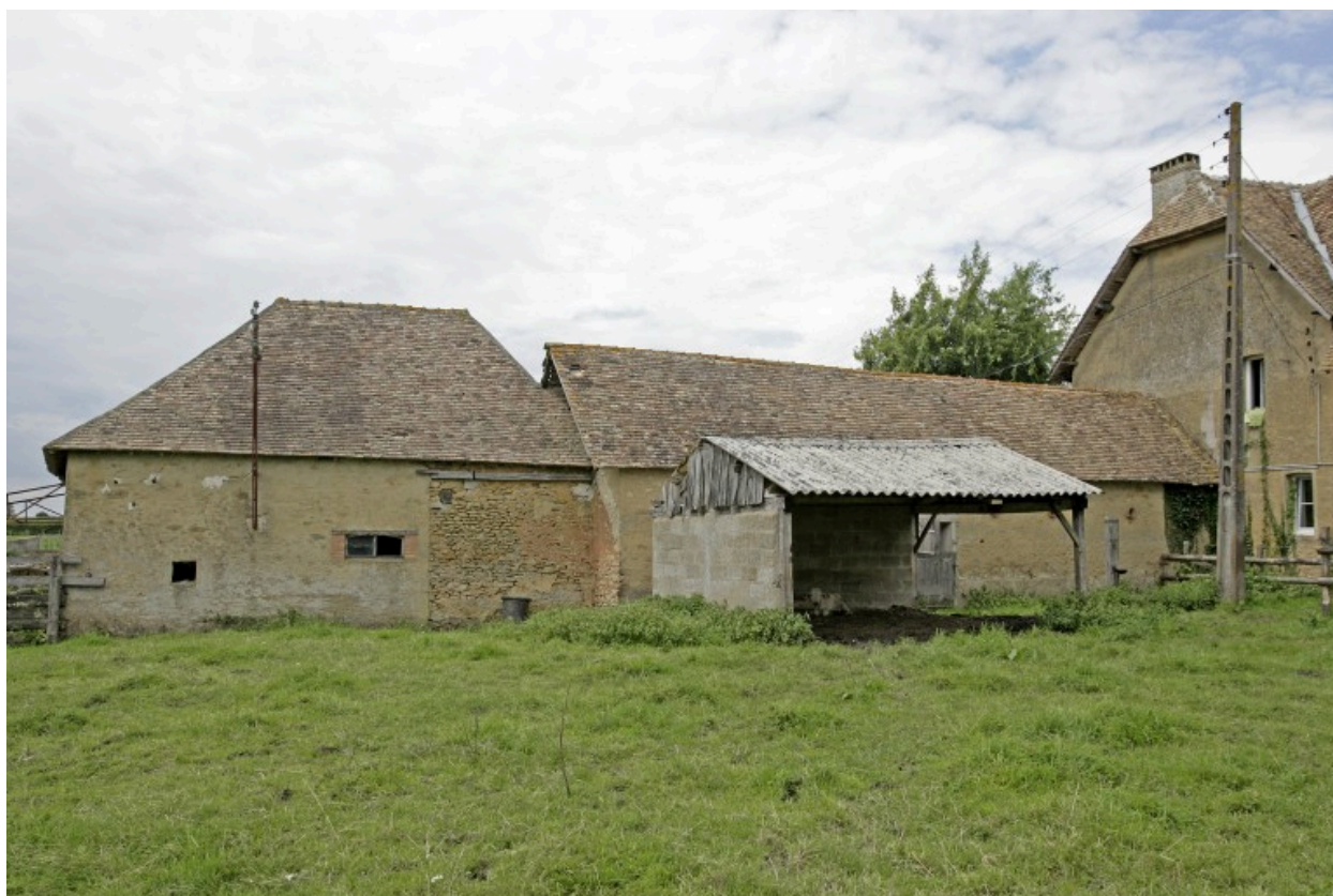
Porcherie et atelier : élévations postérieures.
