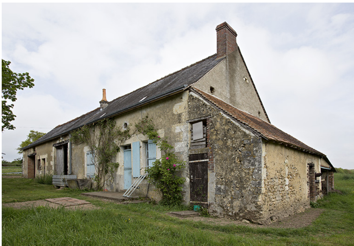
Vue de volume de la ferme bloc à terre depuis le sud-est.
