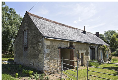
Vue de volume de la ferme bloc à terre depuis le sud-ouest. Phot. Pierre-Bernard Fourny IVR52_20147200324NUCA
