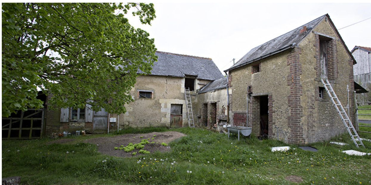
Bâtiments agricoles (buanderie et étables) faisant face à la ferme bloc à terre.
