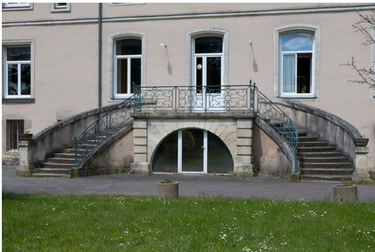
Escalier à deux volées.
