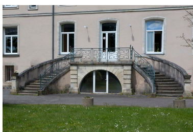
Escalier à deux volées. Phot. Denis Pillet IVR52_20134401935NUCA
