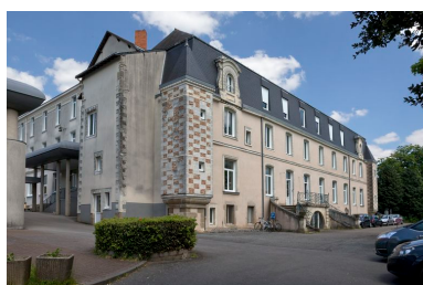
Vue sud-ouest. Phot. Denis Pillet IVR52_20134401936NUCA
