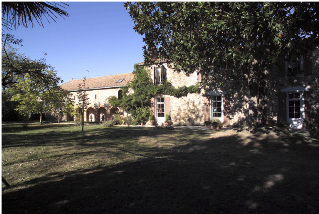
Vue partielle des façades sur le jardin.
