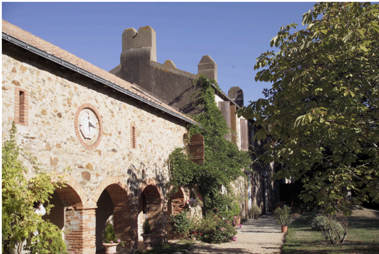
Vue partielle des façades sur le jardin.
