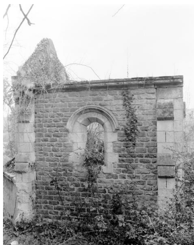
Flanc nord de la chapelle, 1985. Phot. Bruno Rousseau IVR52_19854902009X
