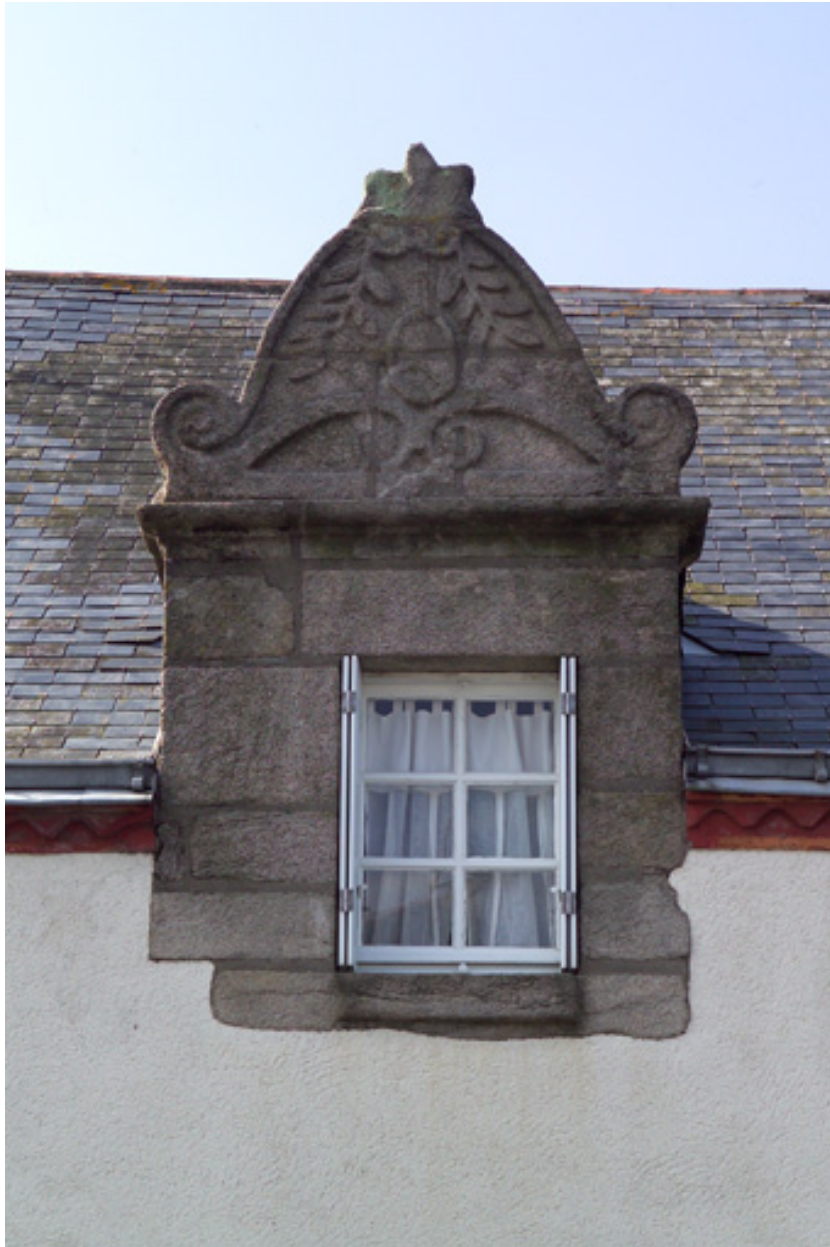
Façade sur rue, détail de la lucarne.
