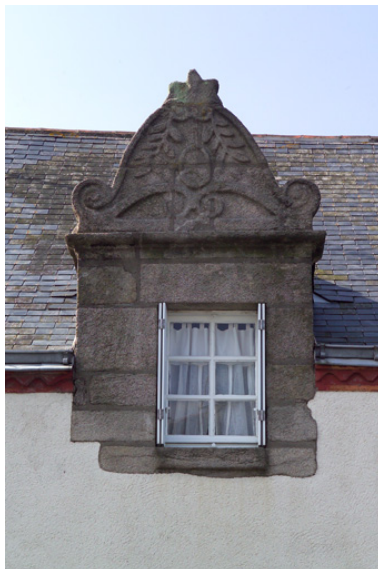
Façade sur rue, détail de la lucarne. Phot. Denis Pillet IVR52_20064402017NUCA
