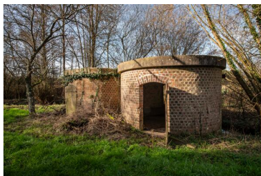
Édicules construits en 1902 pour abriter le bélier Bollée à deux eaux. Phot. Thierry Seldubuisson IVR52_20247200154NUCA
