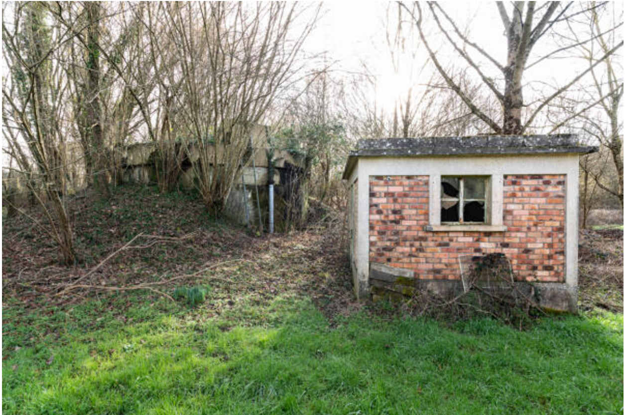
Edicule construit en 1937 pour abriter le bélier supplémentaire. En arrière-plan, le réservoir en béton probablement ajouté vers 1965.
