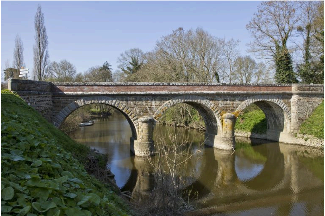
Un des trois ponts de Saint-Fiacre : Bel Abord, construit en 1837, remanié en 1873.
