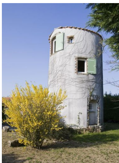
Le moulin du Coin, attesté depuis le XVIIe siècle : vestiges. Phot. Yves Guillotin IVR52_20114400200NUCA
