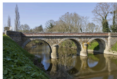
Un des trois ponts de Saint-Fiacre : Bel Abord, construit en 1837, remanié en 1873. Phot. Yves Guillotin IVR52_20114400151NUCA
