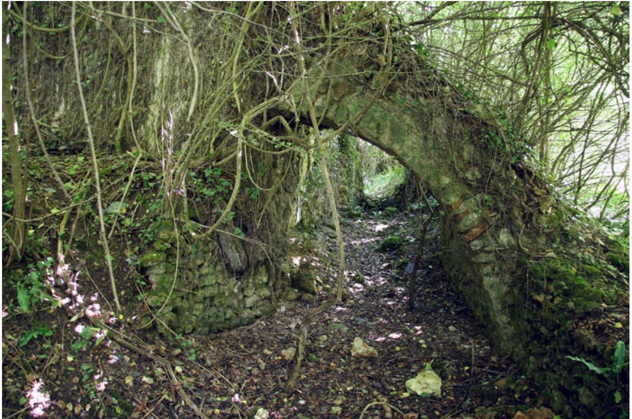
Arc de la rive gauche du bief : vue prise de l'aval.
