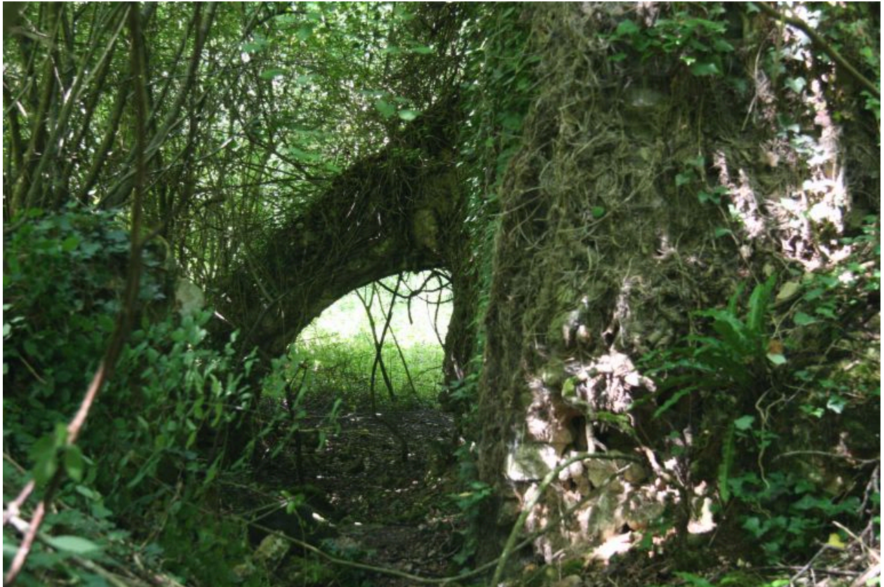
Arc sur la rive gauche du bief, vue prise de l'amont.
