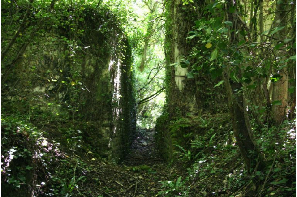
Emplacement de la roue : vue prise de l'aval.
