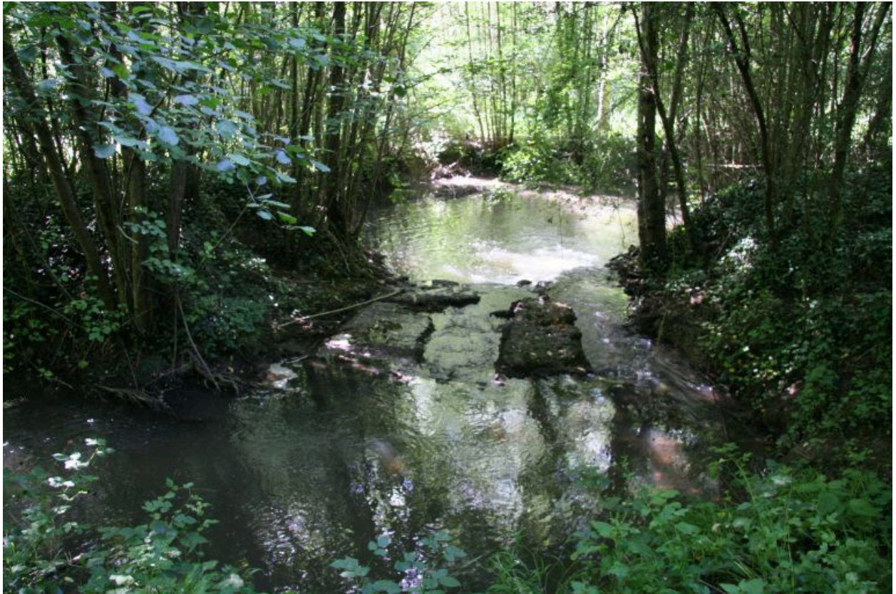
Ancien déversoir en amont sur la rivière de Maulne.
