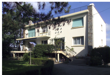
Vue d'ensemble depuis l'entrée. Phot. Denis Pillet IVR52_20044401909NUCA
