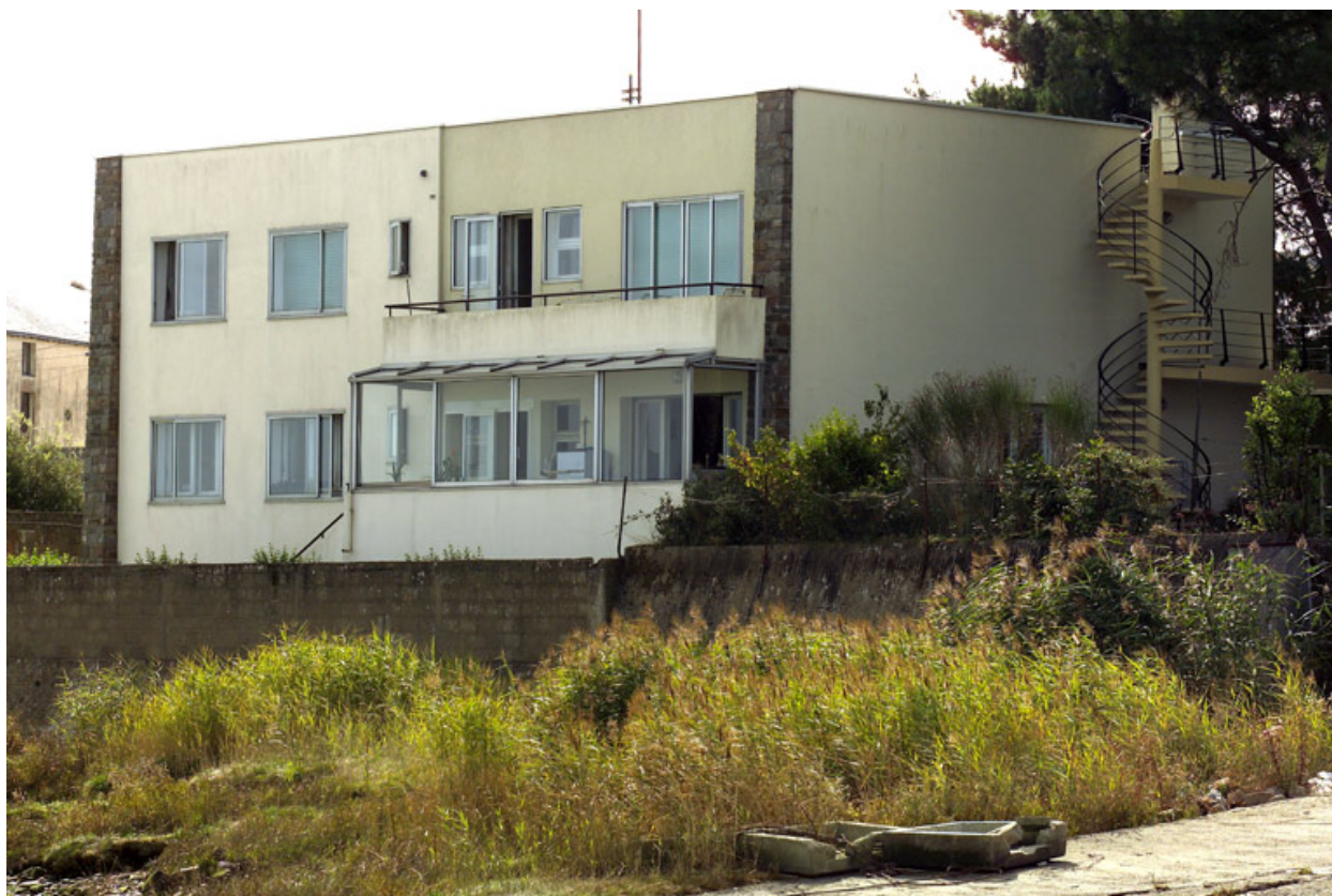
Vue de la façade postérieure.
