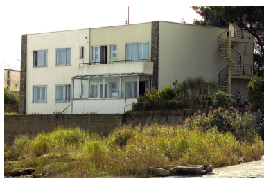
Vue de la façade postérieure. Phot. Denis Pillet IVR52_20044401928NUCA
