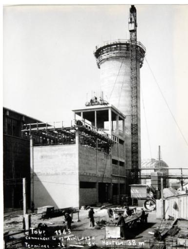
L'atelier urée, construction de la tour nécessaire à la granulation (mise en route, 1963).
