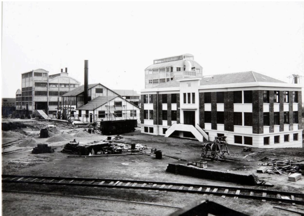
L'usine de production de plomb tétra éthyle en construction (1938) : de gauche à droite, la chaufferie, le mélange, le bâtiment de l'administration.
