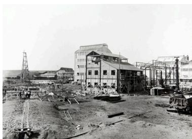
L'usine de production de plomb tétra éthyle en construction (1938) : les bâtiments alliage et récupération, entre le PTE (plomb tétra éthyle) et la Loire (1938).
