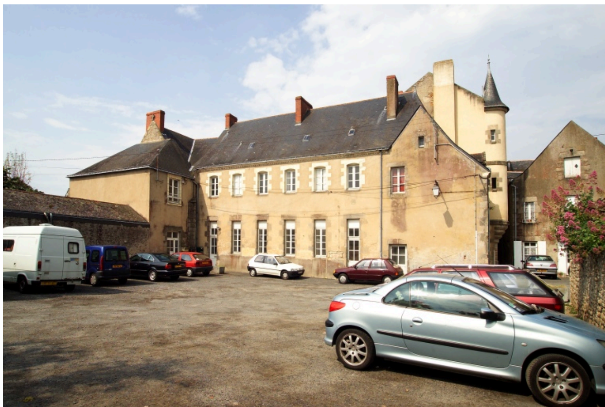
Vue générale de la place saint-Jean vers l'Ouest.
