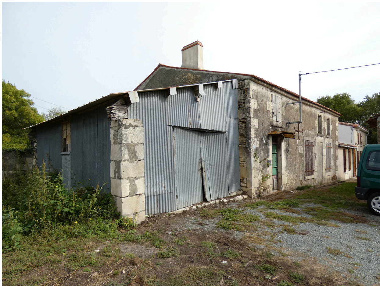
Le logis et le hangar vus depuis l'ouest.
