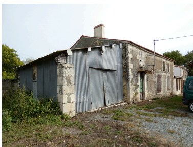
Le logis et le hangar vus depuis l'ouest.
