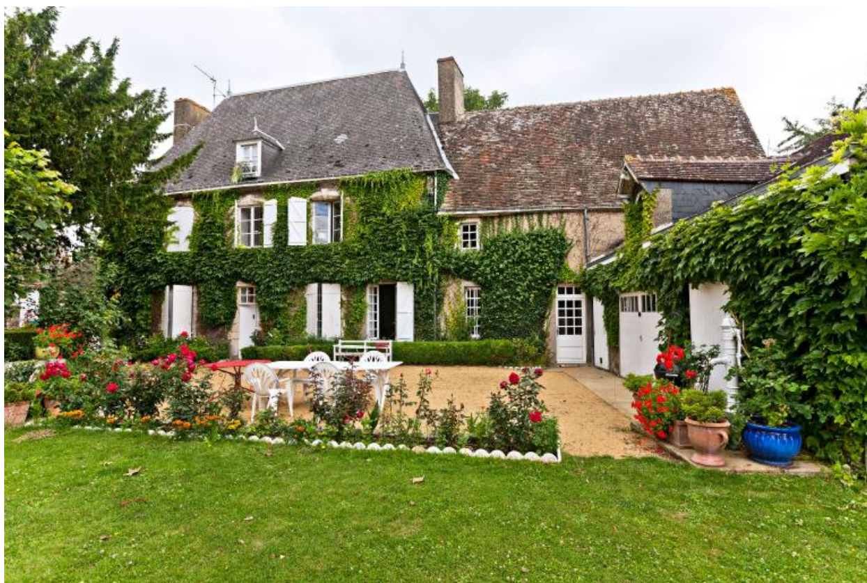
Vue générale depuis le sud.
