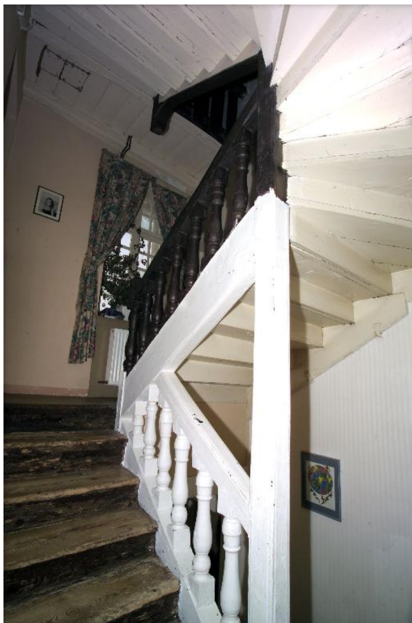
L'escalier, articulant les deux corps de bâtiment, vue prise vers le palier du premier étage.
