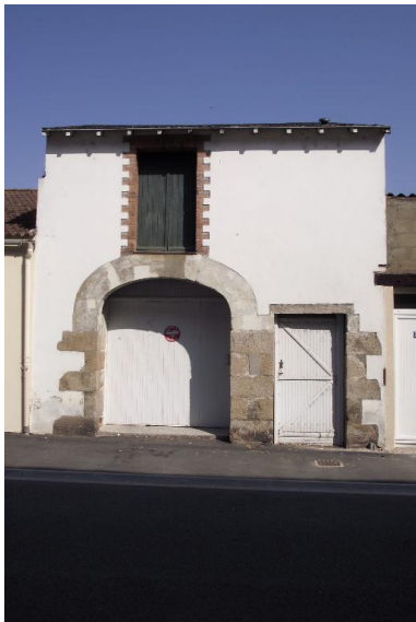
L'ancien magasin sur la rue Pierre-Jubau.
