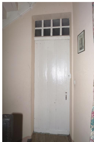
Le corps principal, premier étage, la porte palière. Phot. Denis Pillet IVR52_20034400454NUCA
