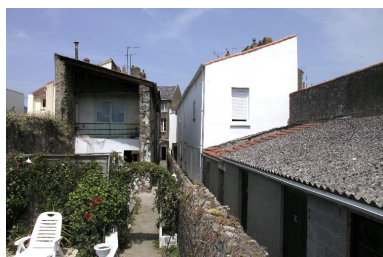
Vue des façades postérieures et des corps secondaires en appentis des maisons n° 35 (à gauche) et n° 33 (à droite). Phot. Denis Pillet IVR52_20034400460NUCA
