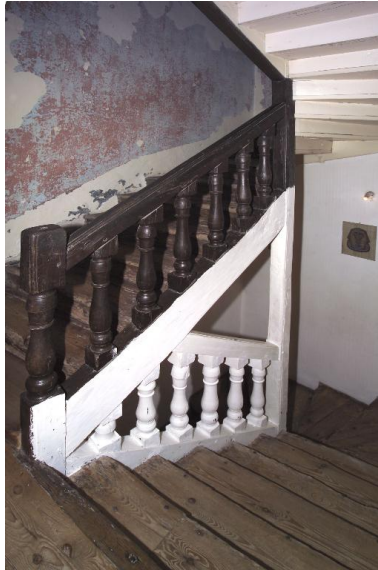
L'escalier, vue prise depuis le premier palier.
