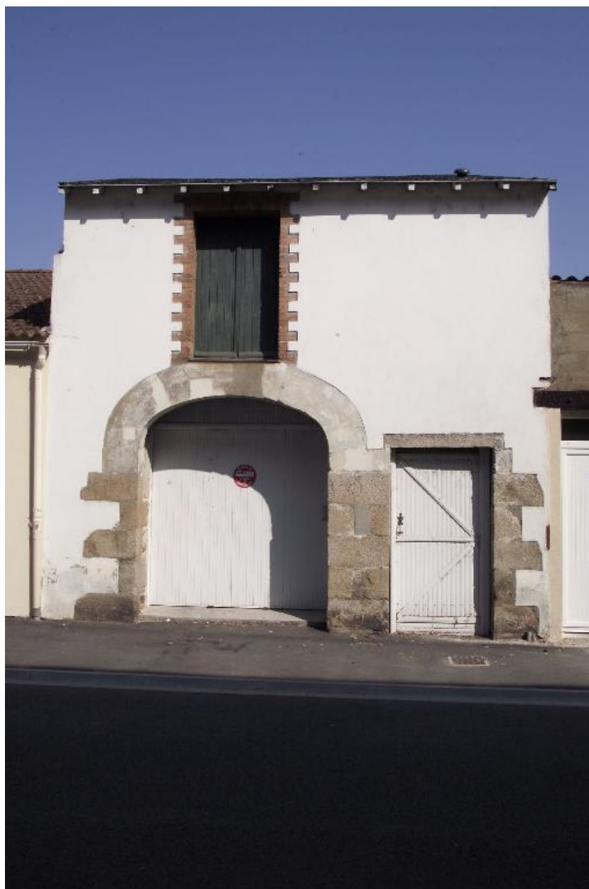
L'ancien magasin sur la rue Pierre-Jubau.
