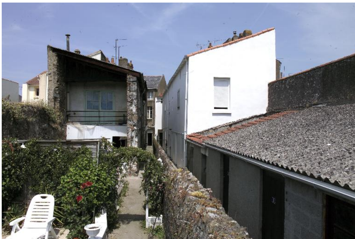
Vue des façades postérieures et des corps secondaires en appentis des maisons n° 35 (à gauche) et n° 33 (à droite).
