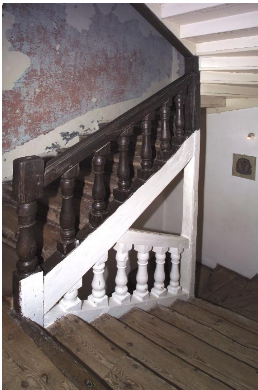
L'escalier, vue prise depuis le premier palier.
