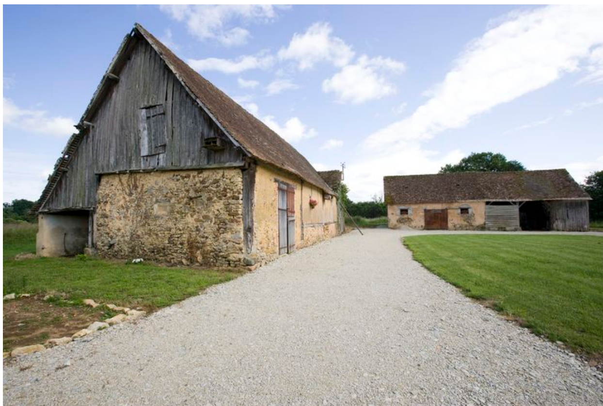
Grange-étables et étables-remise, vues depuis le nord.
