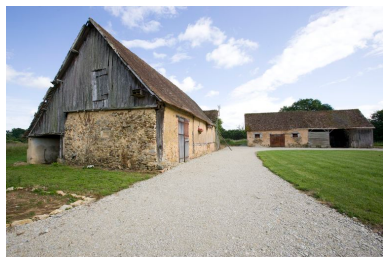
Grange-étables et étables- remise, vues depuis le nord. Phot. Yves Guillotin IVR52_20107202410NUCA
