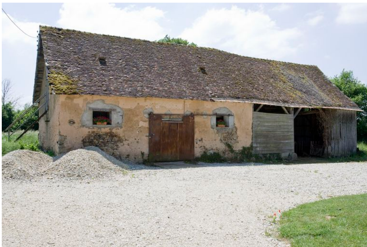
Étables et remise : élévation sur cour.
