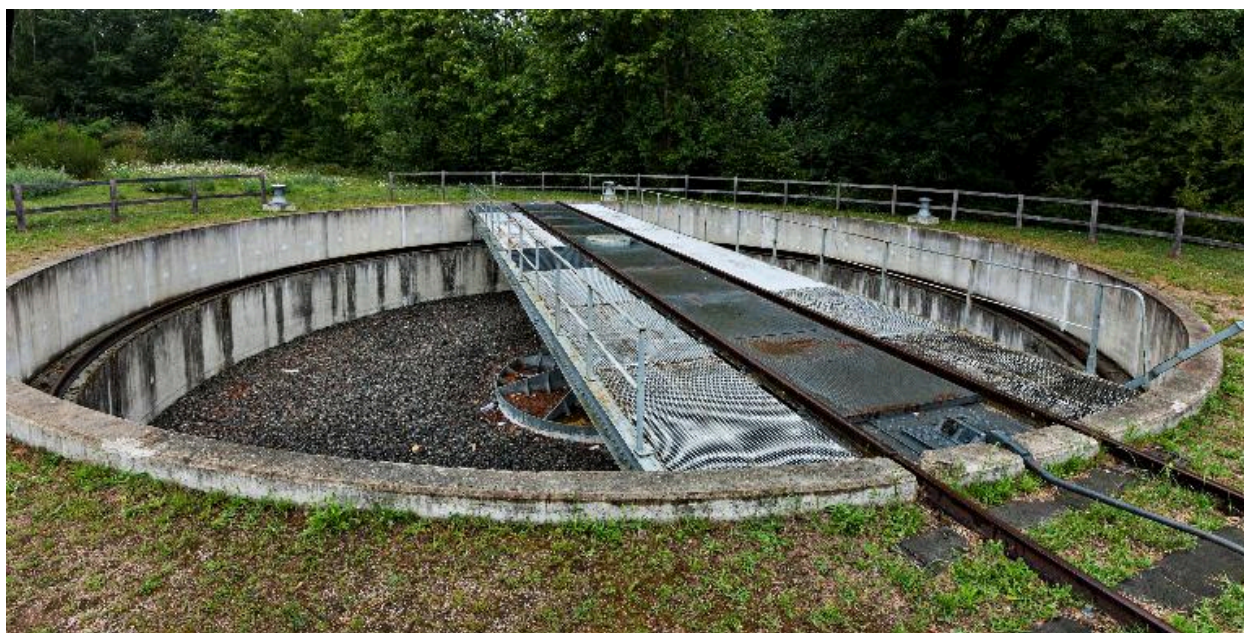
Vue d'ensemble du pont tournant.
