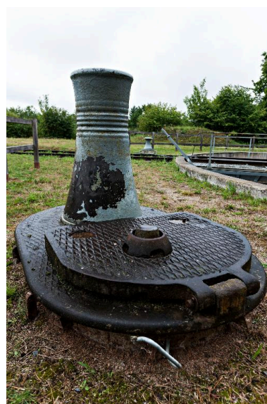
Le cabestan à moteur électrique. Phot. Yves Guillotin IVR52_20177200699NUCA
