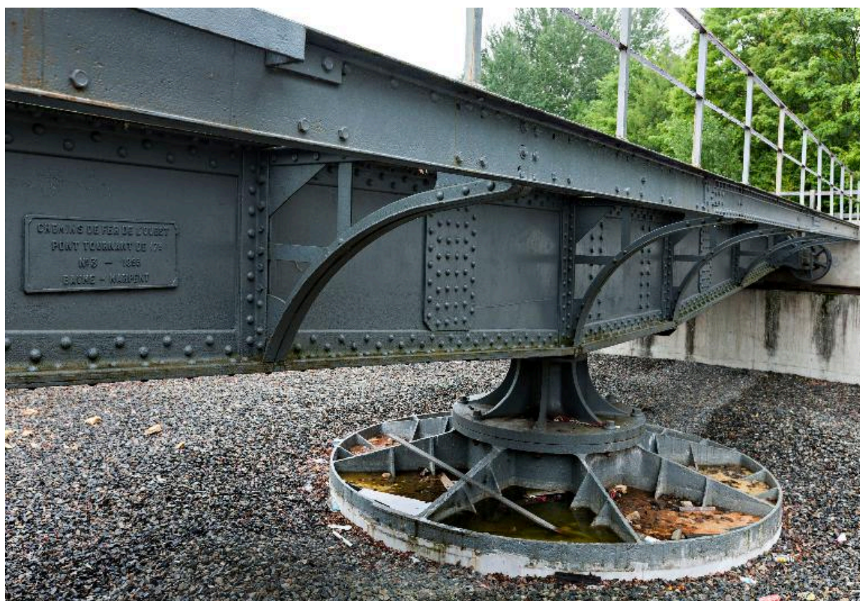
Le tablier du pont.
