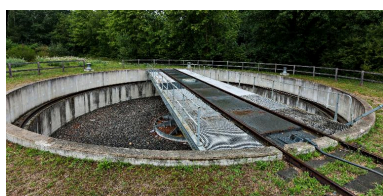
Vue d'ensemble du pont tournant. Phot. Yves Guillotin IVR52_20177200697NUCA
