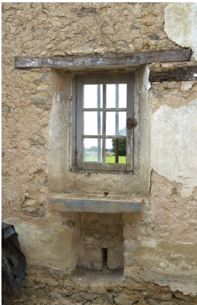
La fenêtre de la pièce centrale du logis et son évier vus de l'intérieur.
