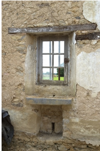
La fenêtre de la pièce centrale du logis et son évier vus de l'intérieur. Phot. François Lasa IVR52_20045301818NUCA
