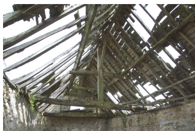
La charpente de la partie est de l'étable vue depuis l'ouest. Phot. François Lasa IVR52_20045301820NUCA
