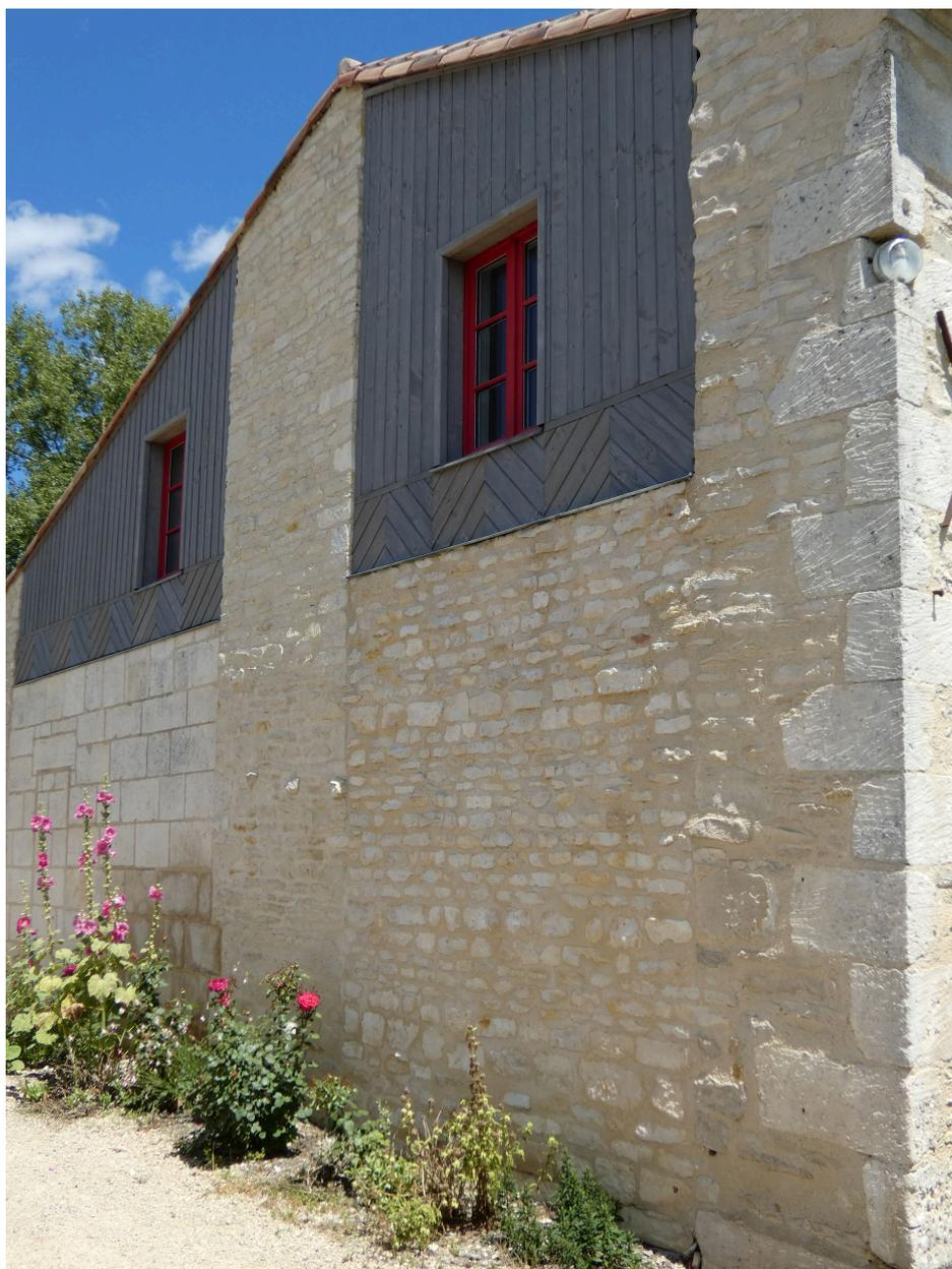
Elévation ouest des dépendances, en moellons et bardeaux de bois restitués.
