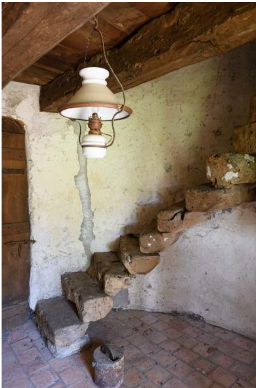
Le moulin à farine dit moulin des Buttes (n° 1) ou moulin de l'Ouche-Neuve. Détail de l'escalier.
