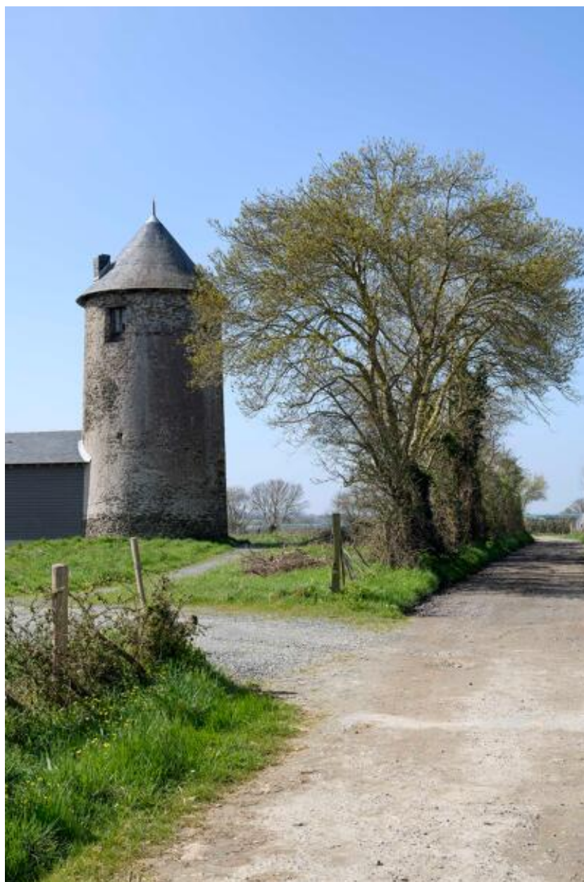
Le moulin Pinot ou Pineau (n°3). Vue d'ensemble depuis l'est.
