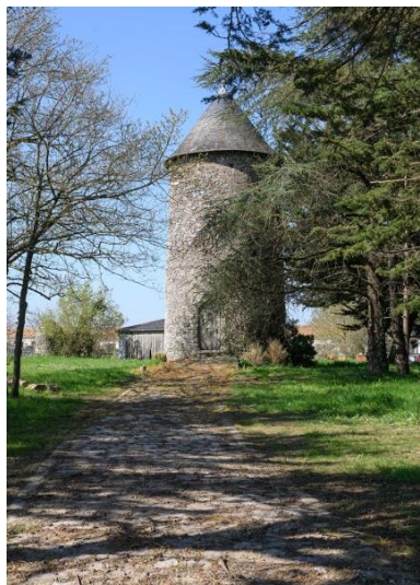
Le moulin à farine dit moulin des Buttes (n° 1) ou moulin de l'Ouche-Neuve. Vue d'ensemble depuis le sud. Phot. Armelle Maugin IVR52_20254900384NUCA
