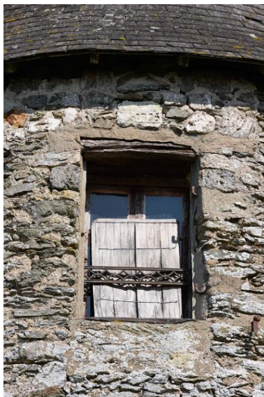
Moulin à farine dit moulin des Buttes (n° 1) ou moulin de l'Ouche-Neuve. Détail de la fenêtre ouest et de la date portée 1735. Phot. Armelle Maugin IVR52_20254900390NUCA
