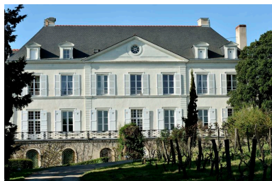
Vue de la façade nord, les vignes en premier plan. Phot. Armelle Maugin IVR52_20174901238NUCA
