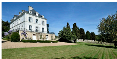
Vue de la façade est. Phot. Armelle Maugin IVR52_20174901280NUCA
