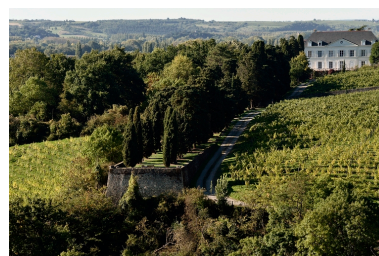
Vue depuis le nord. Phot. Bruno Rousseau IVR52_20154900438NUCA
