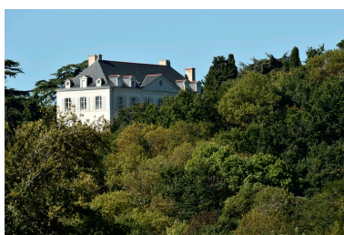
Vue depuis l'est. Phot. Bruno Rousseau IVR52_20154900498NUCA
