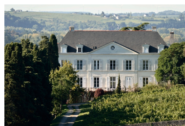
Vue depuis le nord. Phot. Bruno Rousseau IVR52_20154900435NUCA
