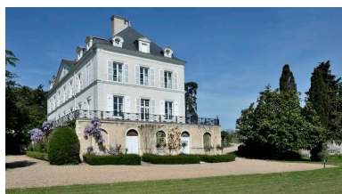
Vue de la façade est. Phot. Armelle Maugin IVR52_20174901279NUCA
