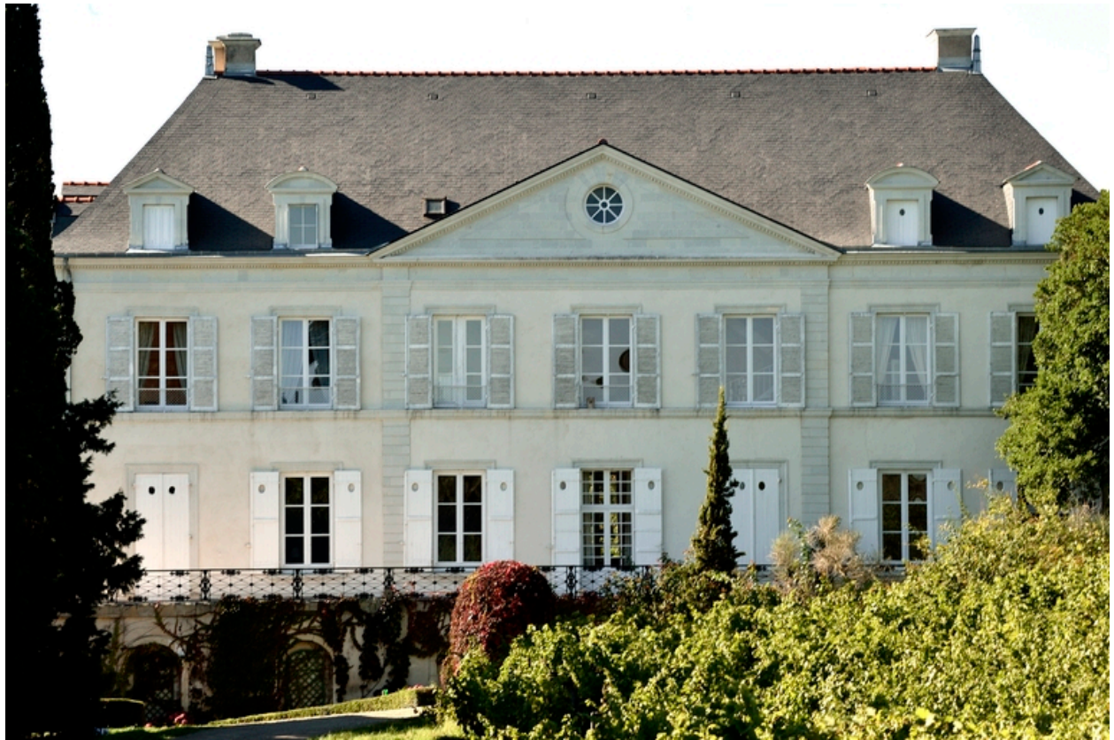
Vue de la façade arrière.
