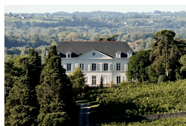
Vue depuis le nord. Phot. Bruno Rousseau IVR52_20154900426NUCA
