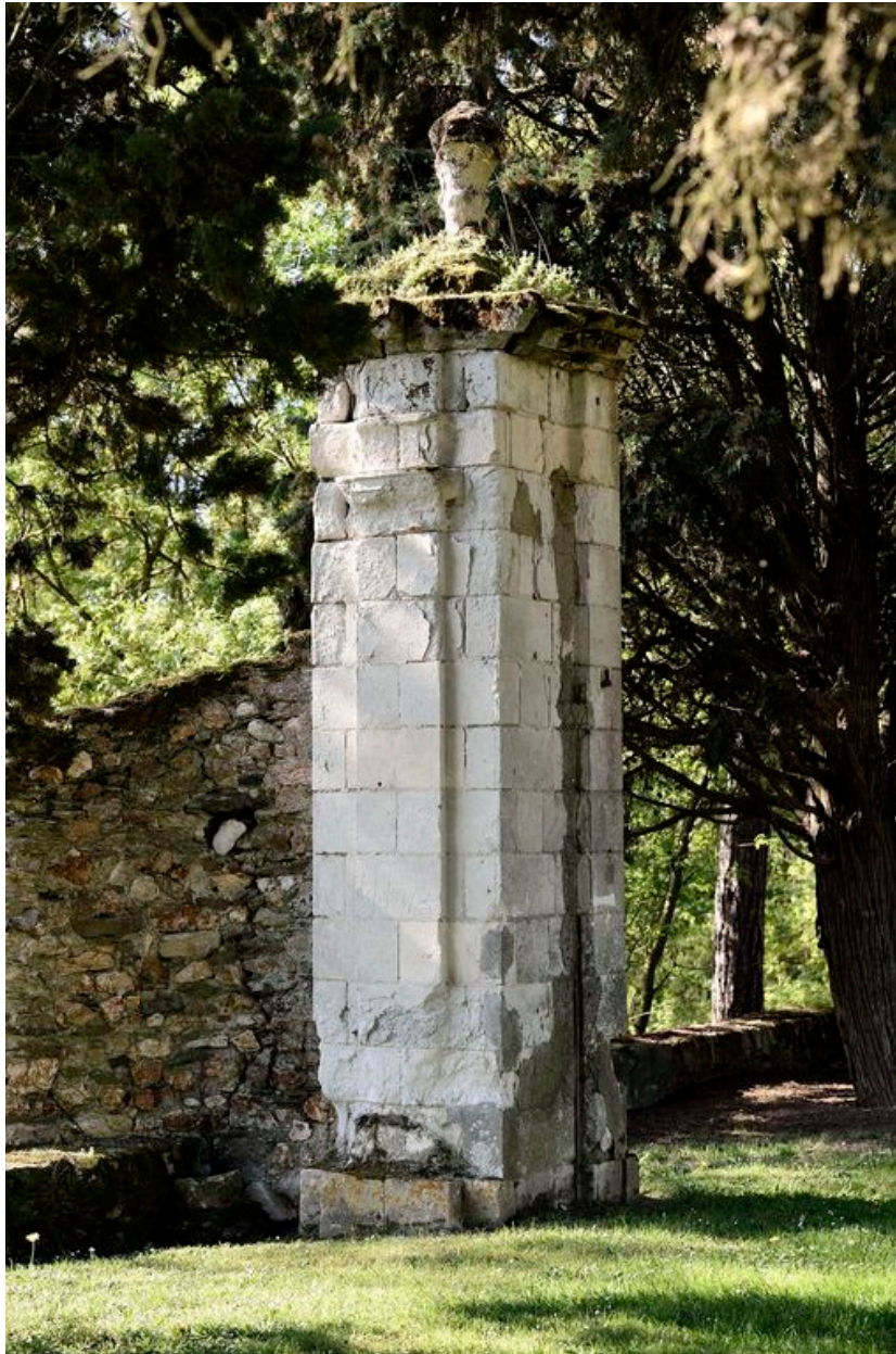
Détail d'un pilier de portail en tuffeau.
