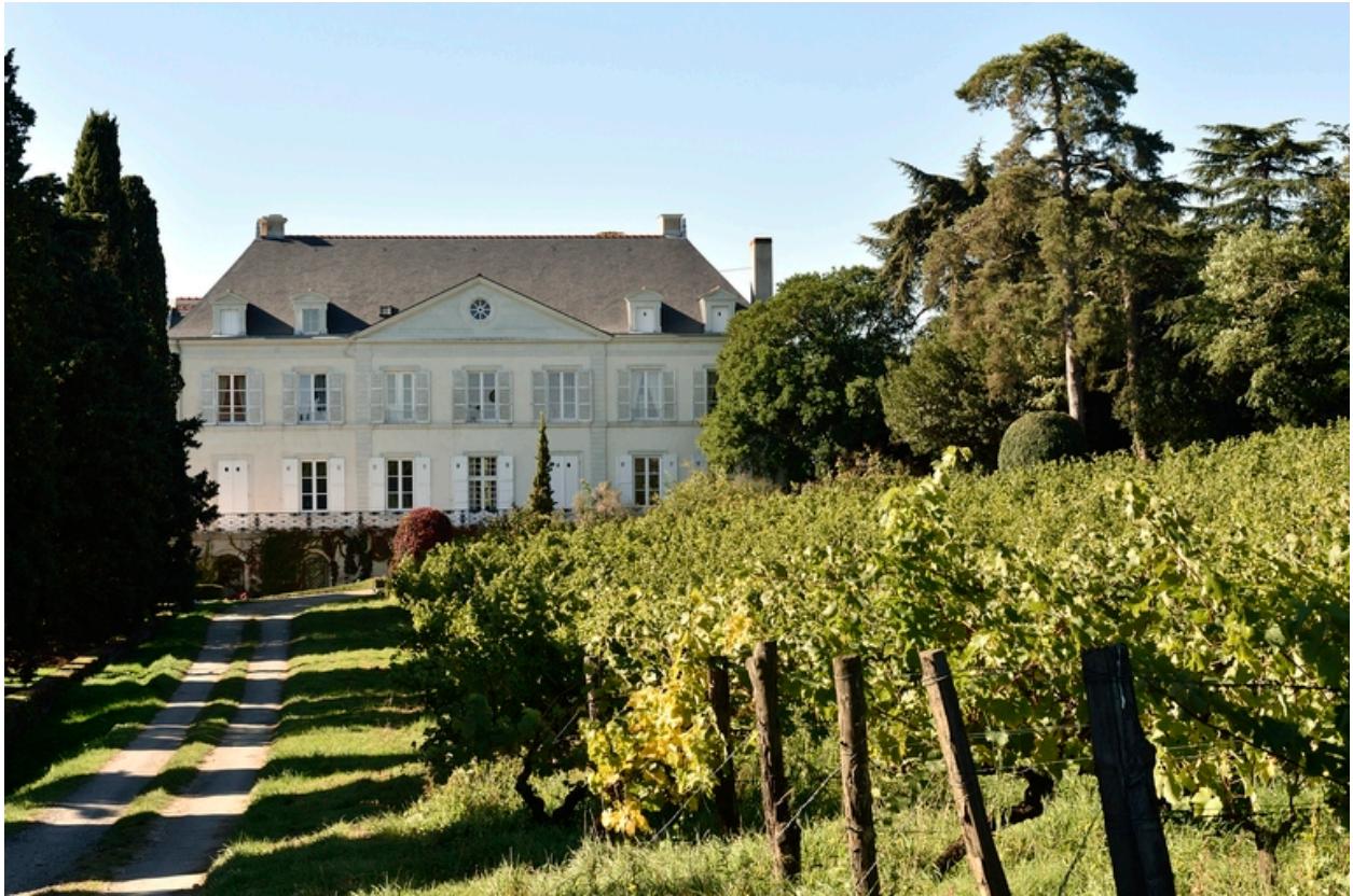
Vue de la façade nord.
