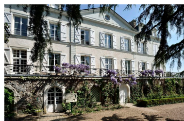
Vue de la façade principale. Phot. Armelle Maugin IVR52_20174901282NUCA
