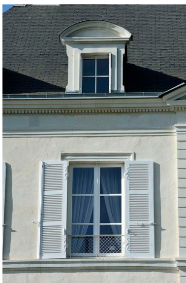
Vue sur les baies. Phot. Armelle Maugin IVR52_20174901235NUCA
