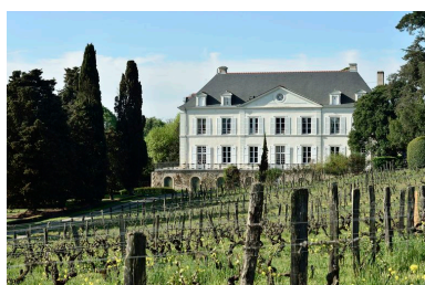
Vue de la façade nord, les vignes en premier plan. Phot. Armelle Maugin IVR52_20174901241NUCA
