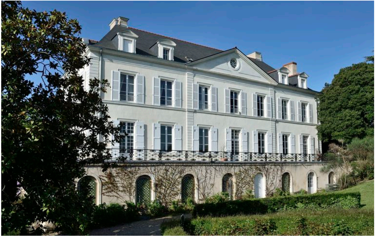
Vue de la façade nord depuis les jardins.
