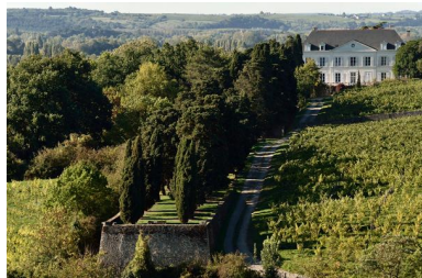
Vue depuis le nord. Phot. Bruno Rousseau IVR52_20154900436NUCA
