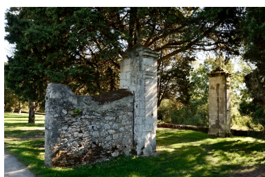
Ancien portail. Deux colonnes en tuffeaux. Phot. Bruno Rousseau IVR52_20154900481NUCA
