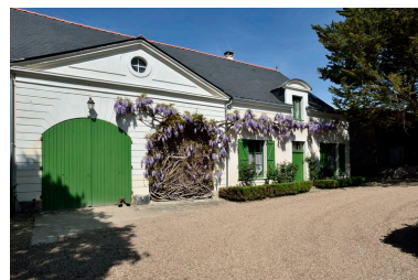
Communs. Phot. Armelle Maugin IVR52_20174901286NUCA
