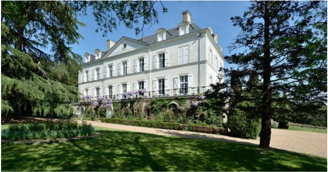
Vue depuis le sud.
