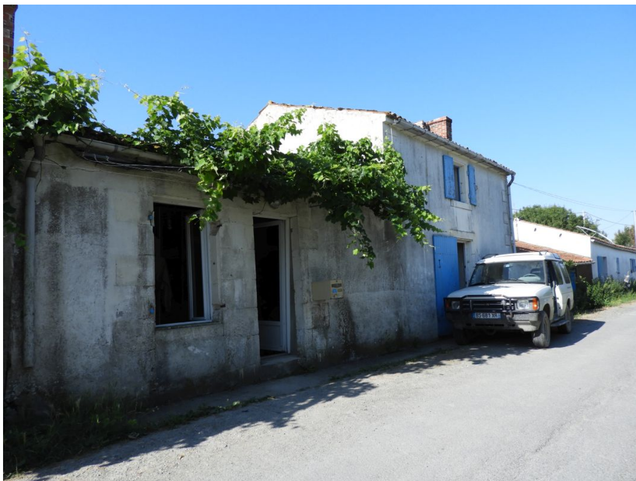
Le logis vu depuis le nord-est.
