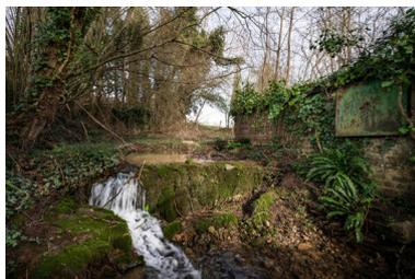
Station de captage depuis l'aval : à l'arrière-plan, le bâtiment envahi par la végétation abrite le captage. A droite, le second bâtiment abrite le bassin de décantation. Au premier plan, le lavoir des riverains reverse l'eau dans le cours naturel.
