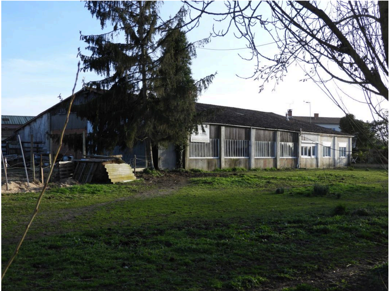
Ancien atelier (?) au nord-est du logis, vu depuis le nord-est.
