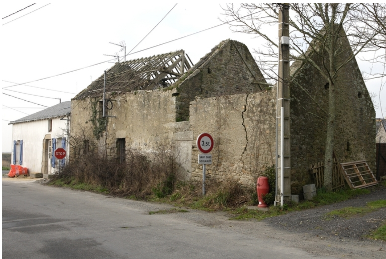
Vue d'ensemble du 26 rue de Kérignon.
