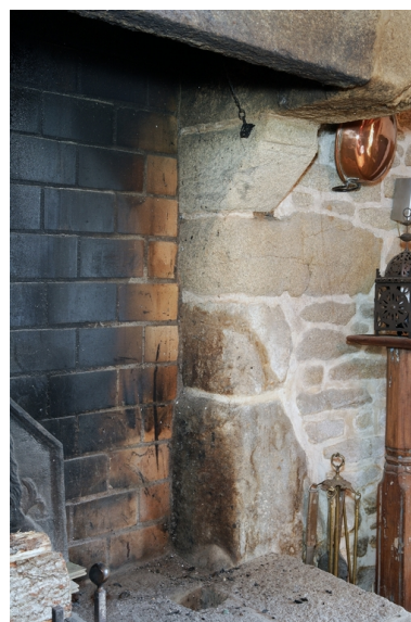
Détail du jambage chanfreiné de la cheminée (10 route des Marais). Phot. Denis Pillet IVR52_20084400043NUCA
