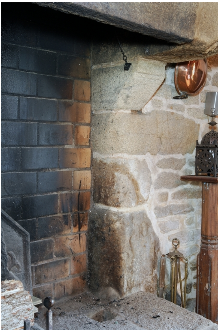
Détail du jambage chanfreiné de la cheminée (10 route des Marais).
