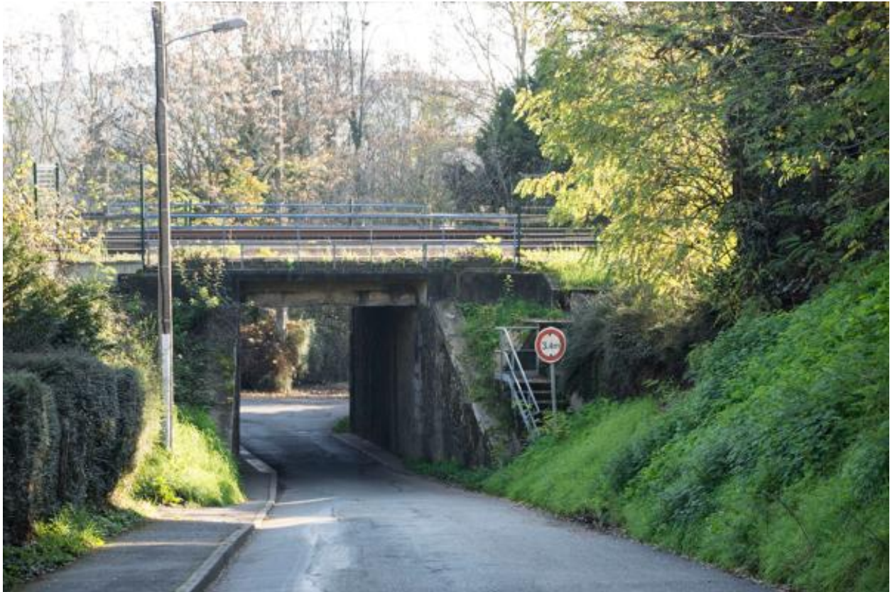
Vue du pont de chemin de fer au chemin de la Perronière.
