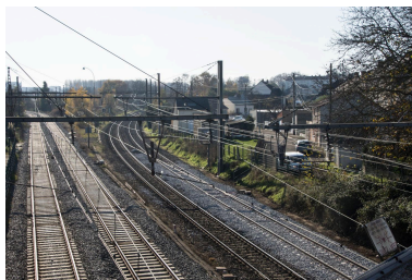
Vue de la voie de chemin de fer traversant le quartier de Saint-Georges-du-Plain. Phot. Bruno Rousseau IVR52_20207201160NUCA
