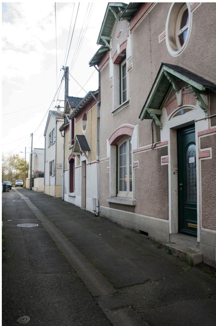
Vue de la rue de l'Arche-Chaumard.
