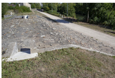
Vue du système d'épanchement des eaux sur digue au-dessus du chemin de halage. Phot. Pierre-Bernard Fourny IVR52_20197202202NUCA
