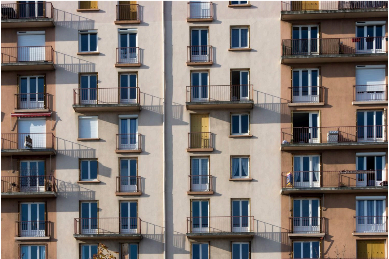
Détail de la façade principale de l'immeuble collectif place du Pâtis.
