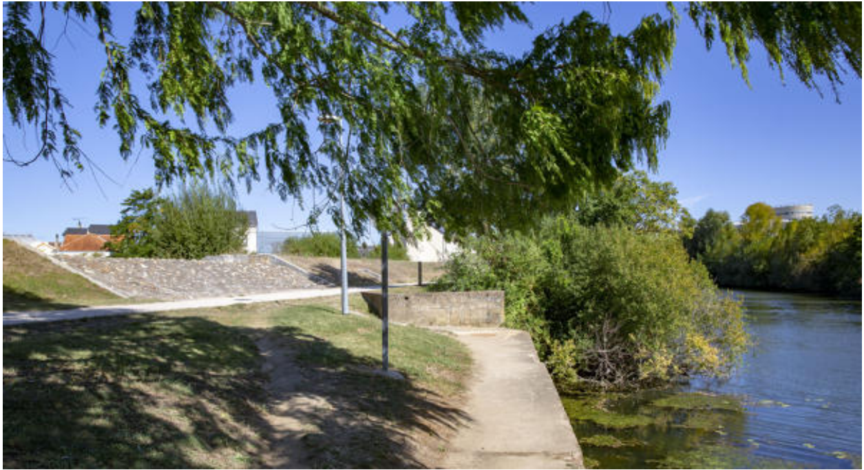
Vue de la rive ouest de la Sarthe.
