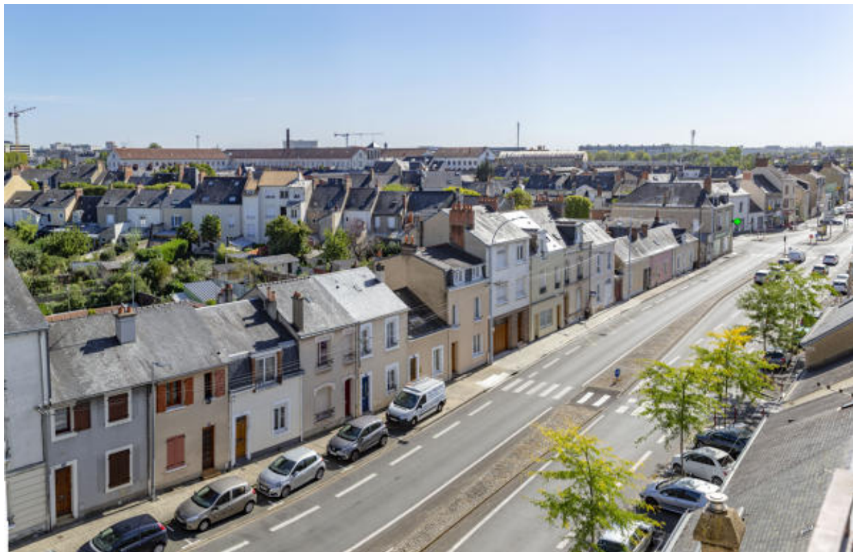
Vue de l'avenue de la Libération vers le sud.
