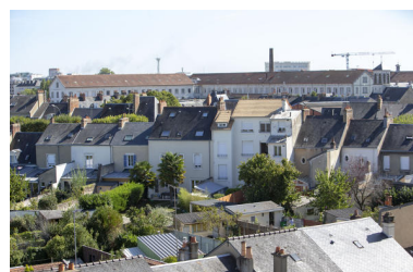
Vue du c#ur d'ilot donnant sur le boulevard Anatole France avec la Manufacture des tabacs en arrière plan. Phot. Pierre-Bernard Fourny IVR52_20197202211NUCA
