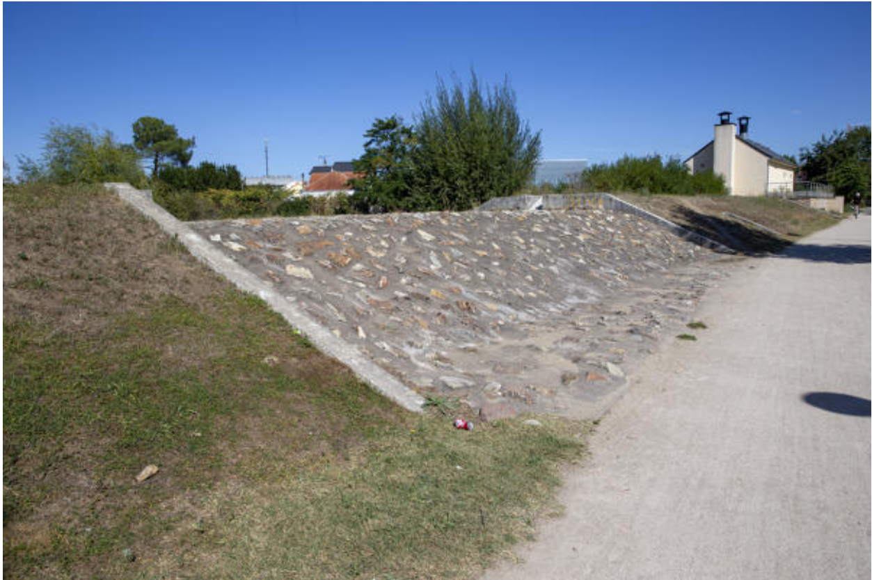
Vue de la digue maçonnée le long du chemin de halage de la Sarthe.
