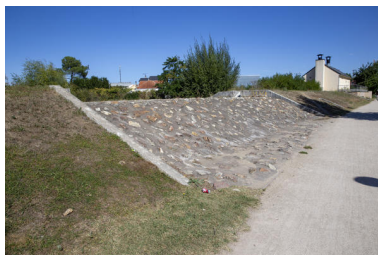
Vue de la digue maçonnée le long du chemin de halage de la Sarthe. Phot. Pierre-Bernard Fourny IVR52_20197202201NUCA
