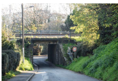
Vue du pont de chemin de fer au chemin de la Perronière. Phot. Bruno Rousseau IVR52_20207201163NUCA
