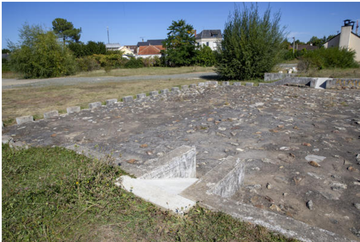
Vue de la digue maçonnée le long du chemin de halage de la Sarthe vers l'ouest.
