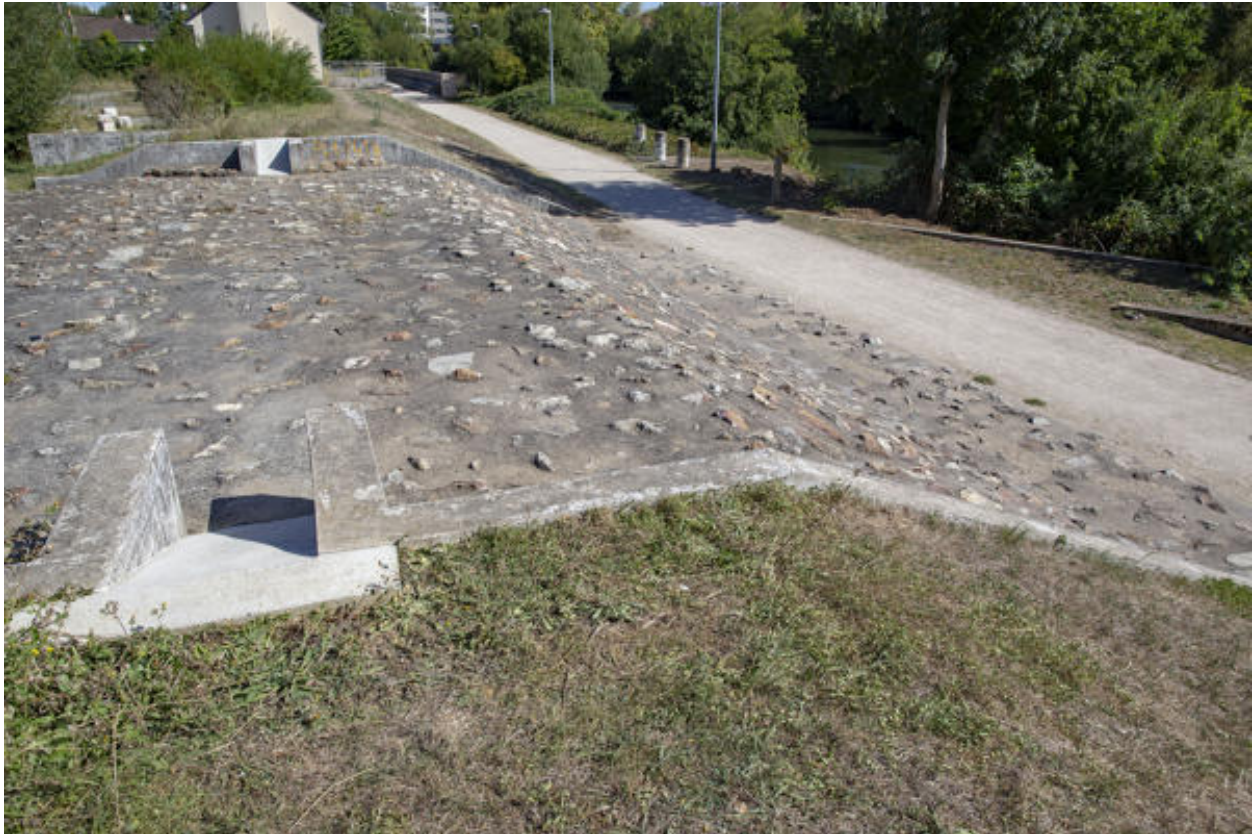
Vue du système d'épanchement des eaux sur digue au-dessus du chemin de halage.
